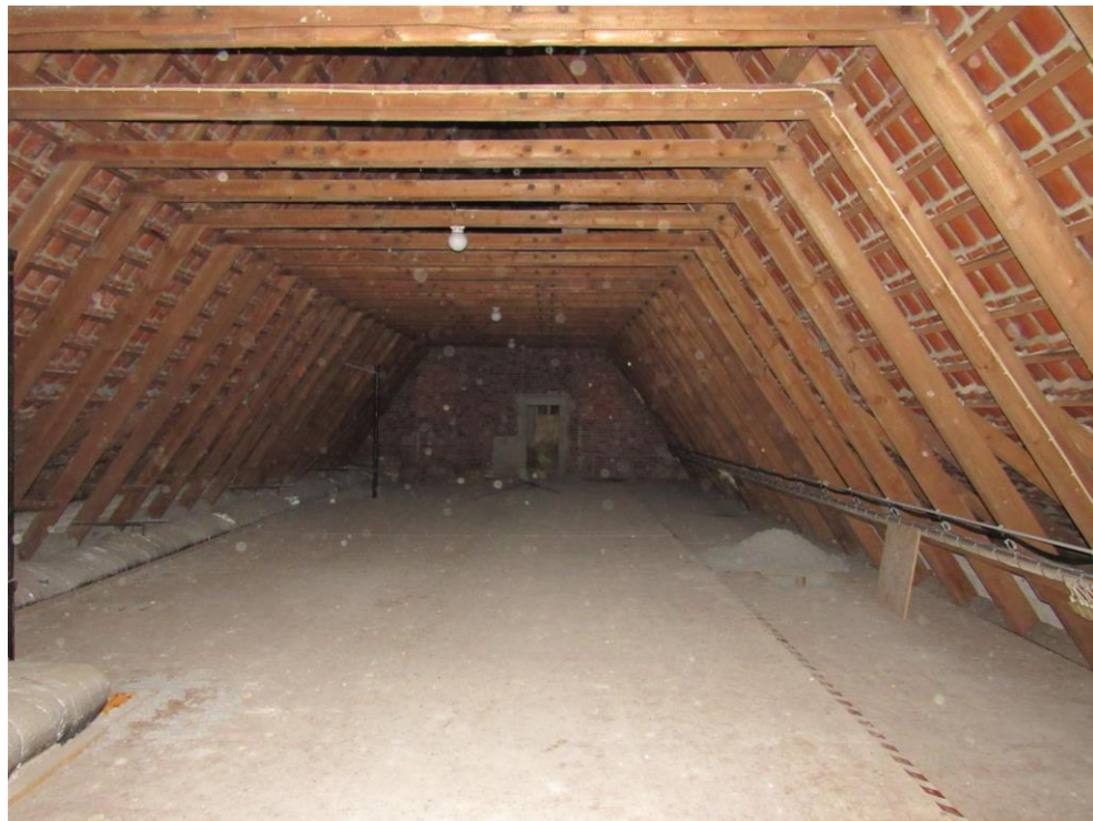
Dachraum Trakt B, keine feststellbaren Schäden an der Holzkonstruktion.
