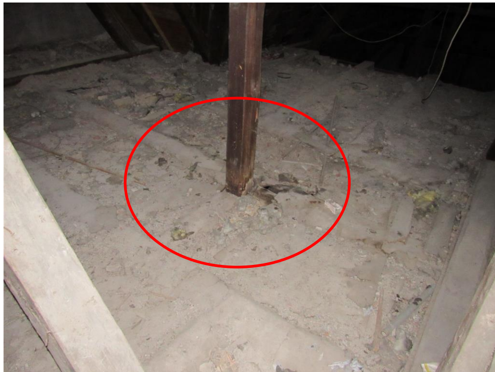
Stütze auf Balkenlage oberhalb der Decke (siehe vorheriges Bild)
