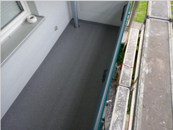
Balkonböden sind beschichtet
