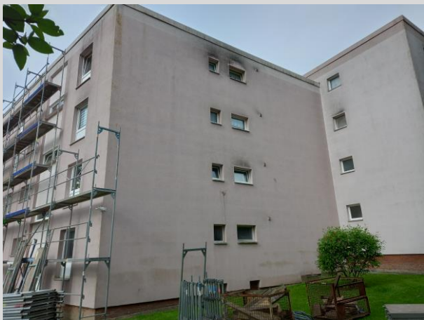
Eckbereich Nordfassade wird eingerüstet
