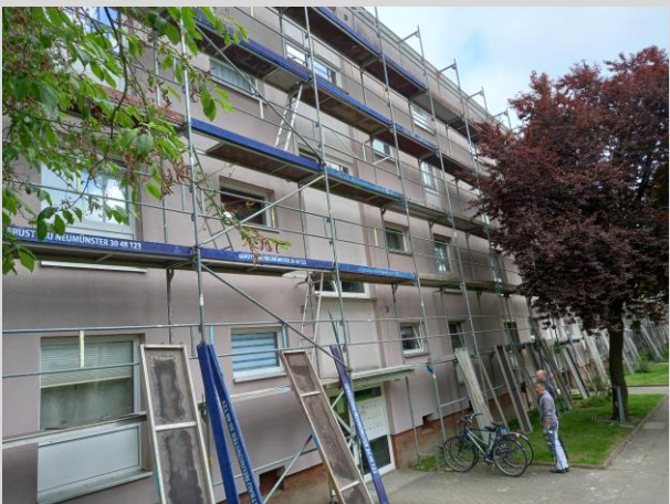
Ostfassade wird eingerüstet
