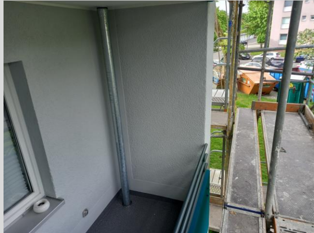
Regenfallrohrleitungen sind montiert
