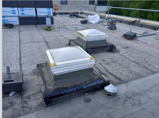
Die Dachlichtkuppeln werden erneuert
