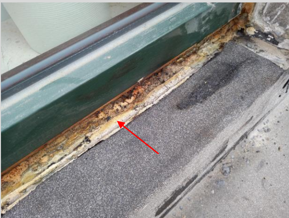
Anschlusspunkt wird mit Crylspachtel aufgefüllt
