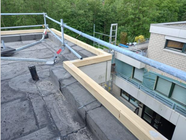
Der Randbalken wird montiert
