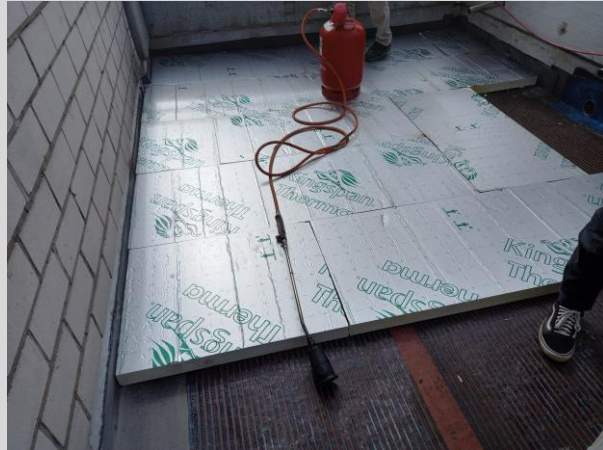
Die neue Dämmlage wird verlegt
