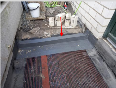
Abdichtung zur Nachbarterrasse
