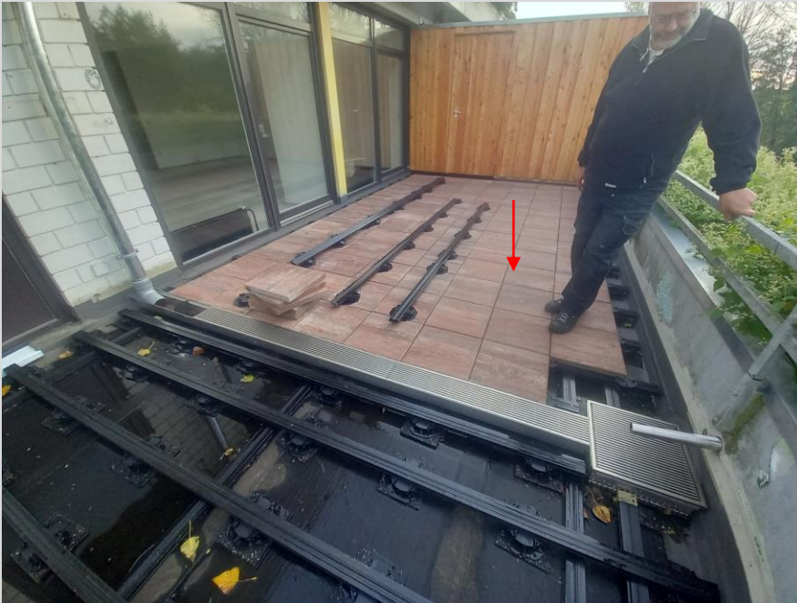
Verlegter Belag auf der Dachterrasse Walke
