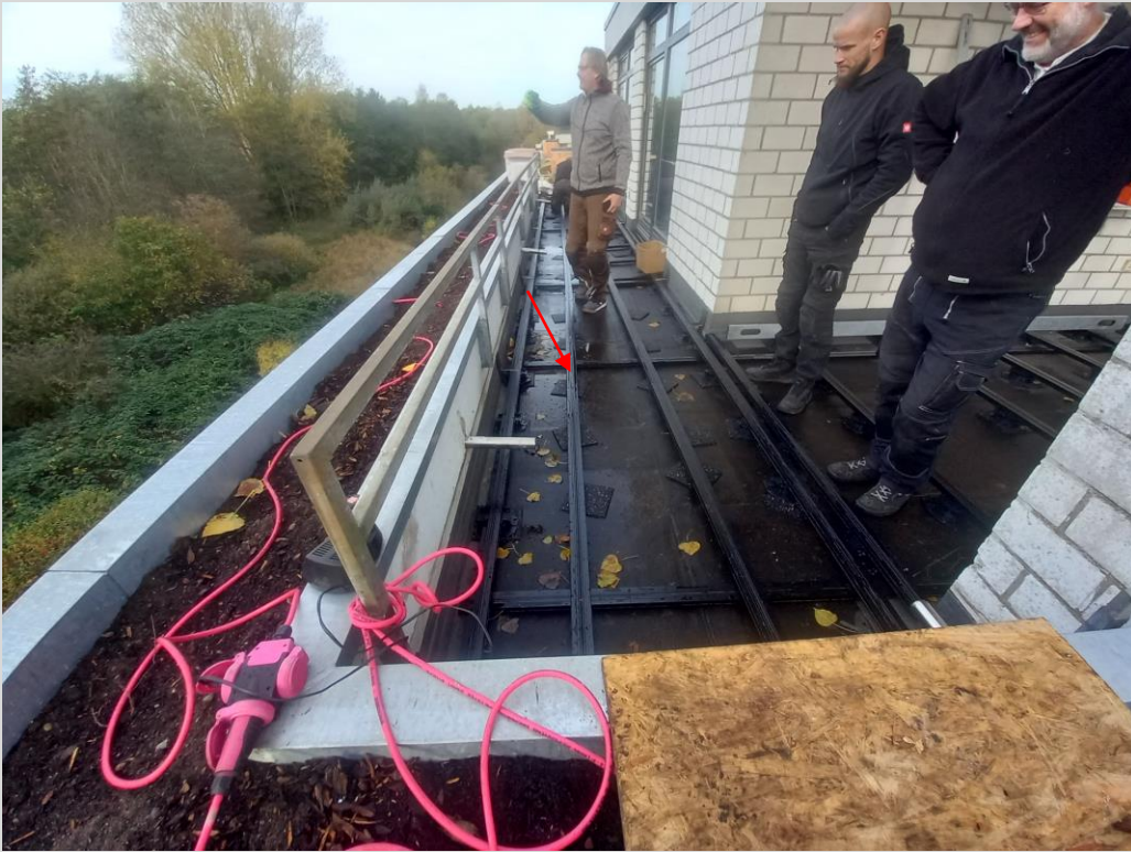
Die Unterkonstruktion wird verlegt
