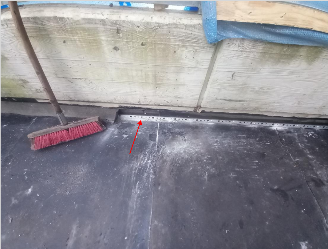
Mechanische Befestigung im Randbereich
