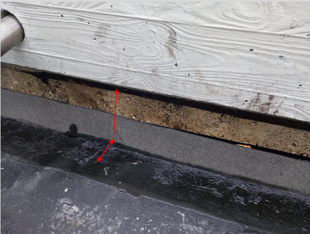
Die Schlussabdichtung mit Flüssigkunststoff folgt
