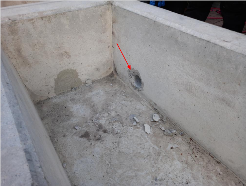
Neue Kernbohrung durch den Pflanztrog hergestellt
