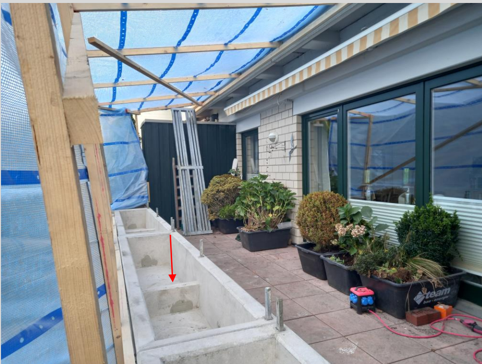
Beginn der Abdichtungsarbeiten an den Pflanztrögen geplant
