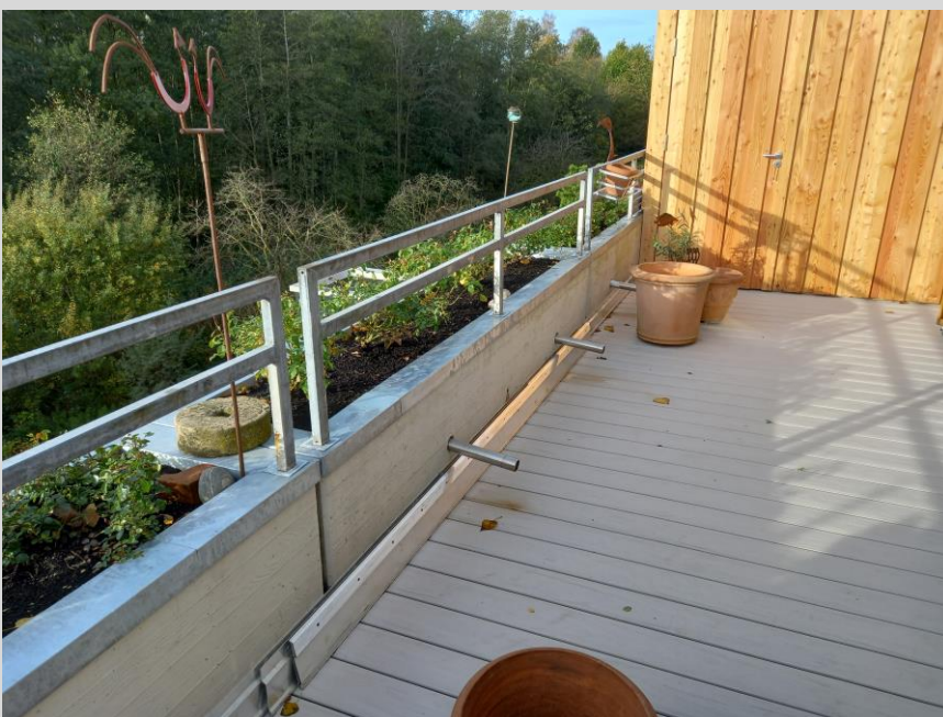
Der Bodenbelag ist eingebaut
