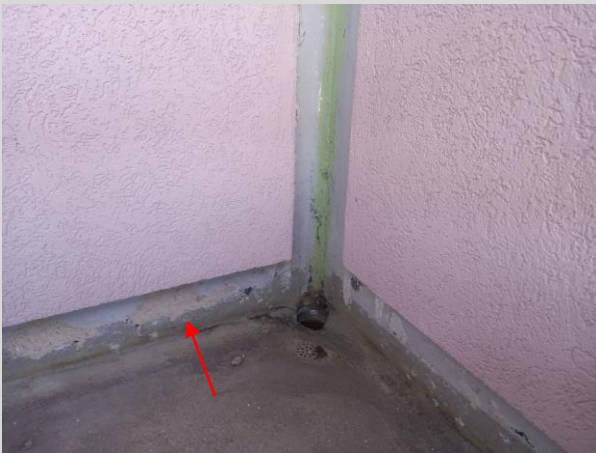
Regenfallrohrleitungen wurden entfernt
