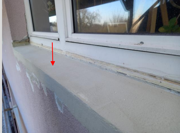
Untergrund für Dichtebene wird hergestellt
