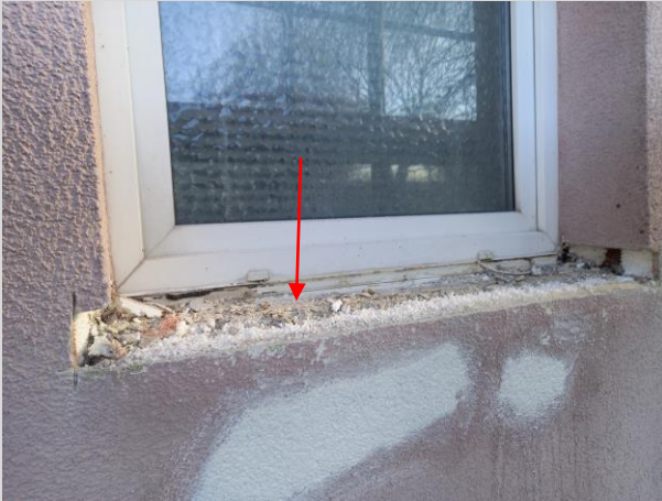
Sohlbänke sind demontiert
