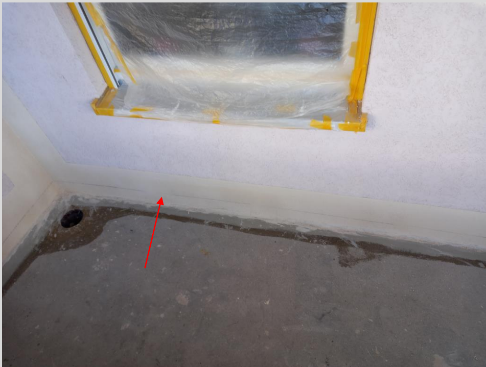
Die Dämmung wurde ergänzt und verputzt
