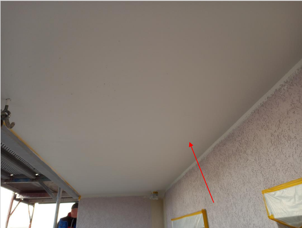
Die Unterseiten der Balkondecken sind gestrichen
