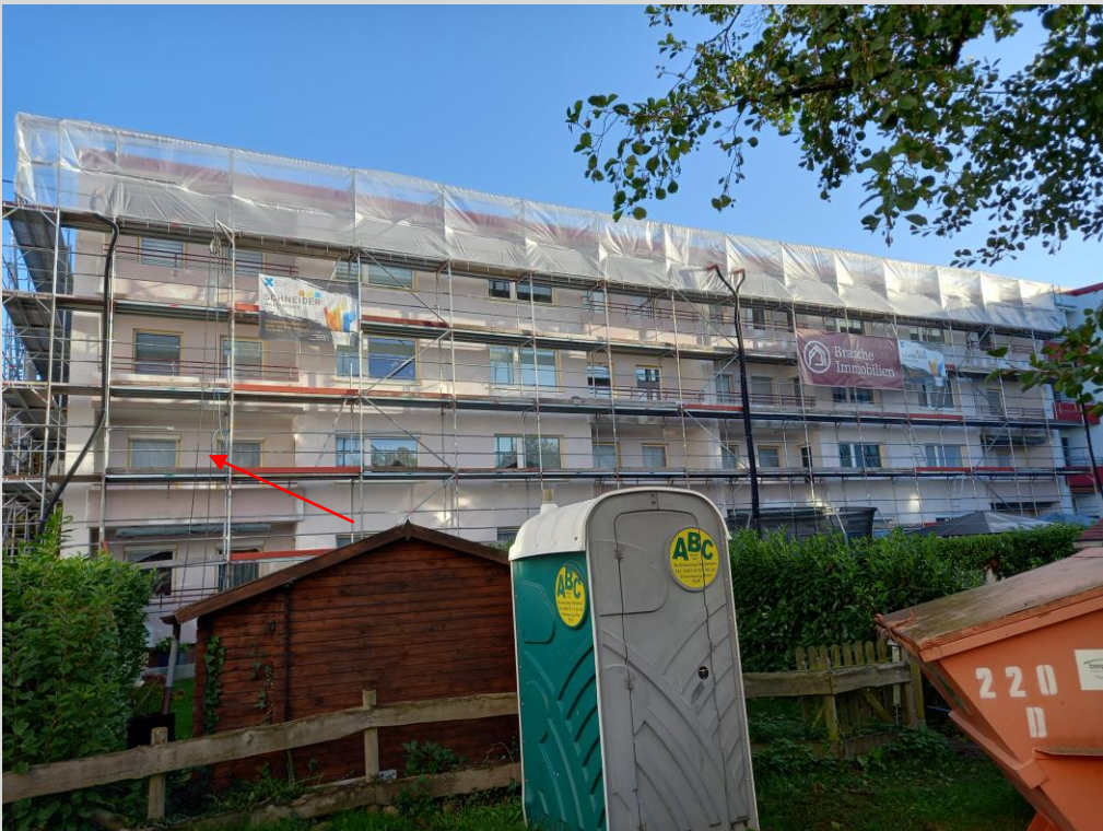
Die Fassadenflächen auf den Balkonen werden gestrichen
