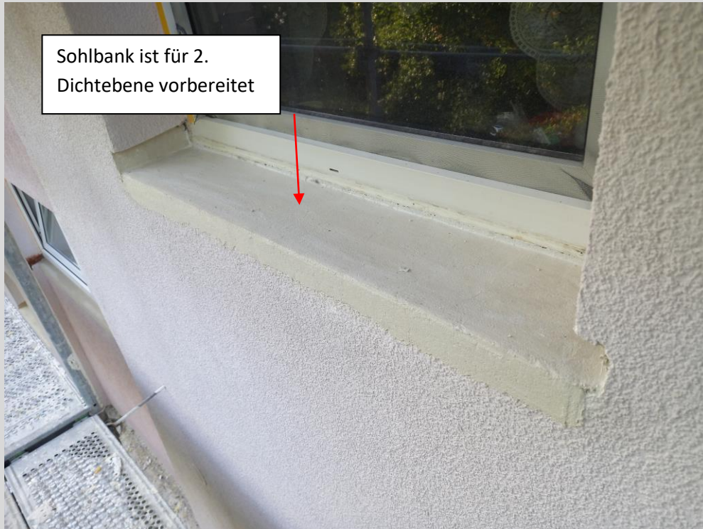
Die Sohlbänke sind demontiert, die Fläche für die 2. Dichtebene vorbereitet
