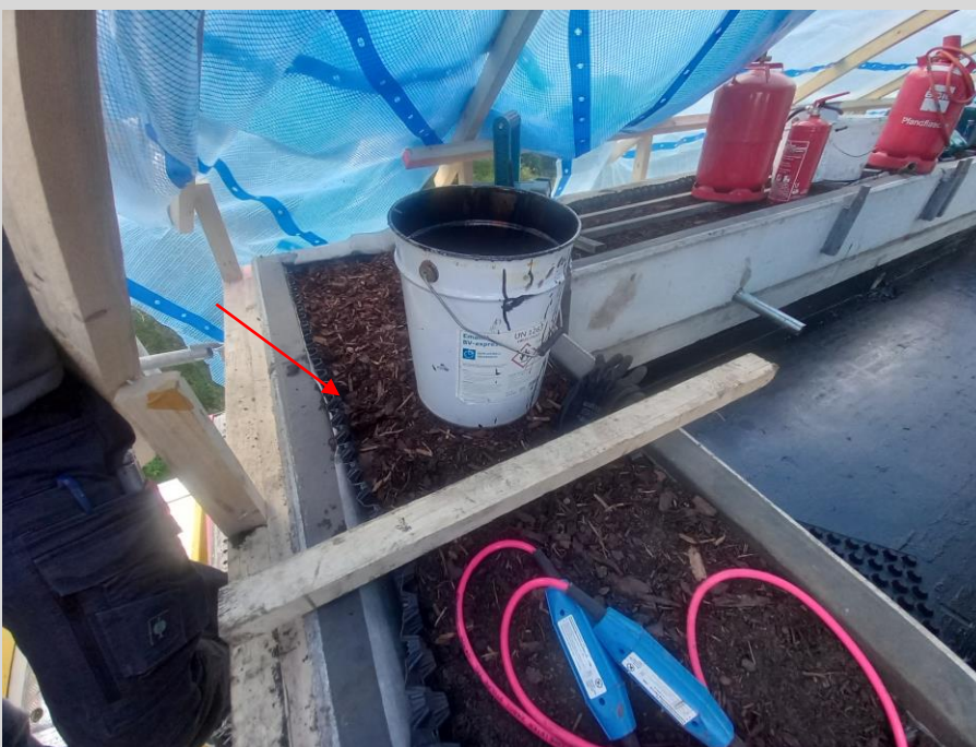
Die Pflanztröge sind fertig gestellt
