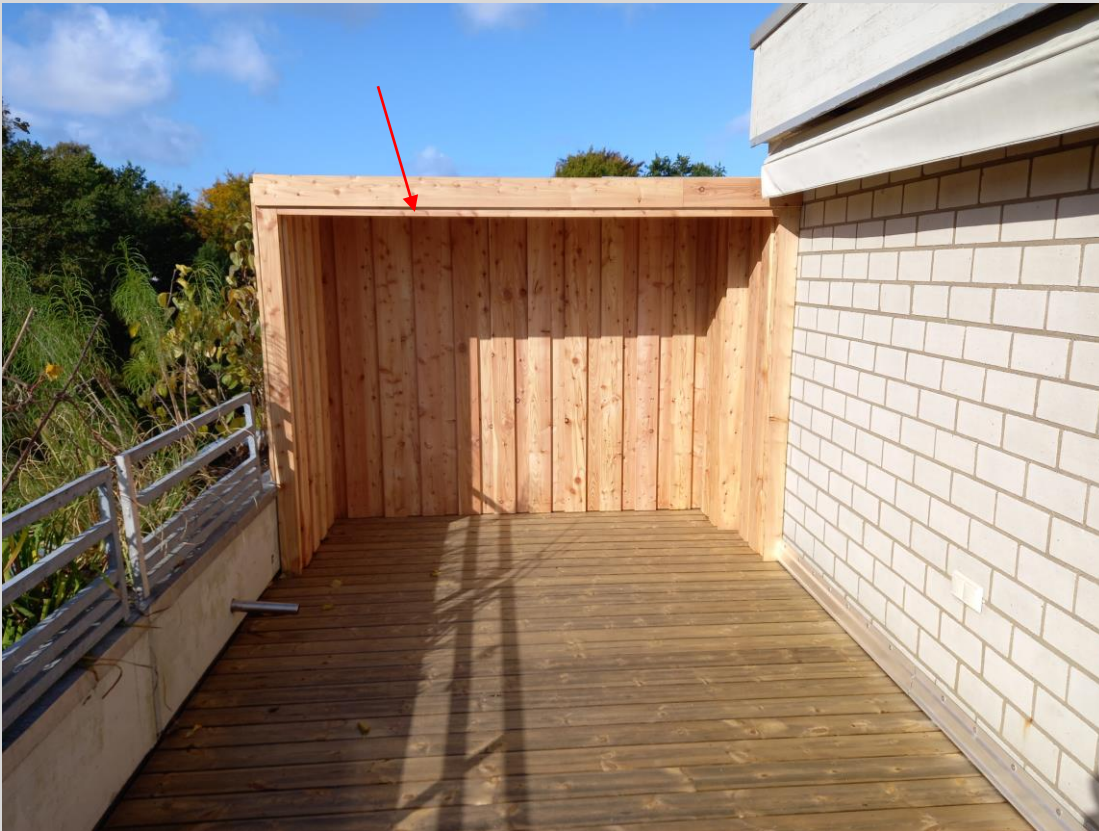
Fertig gestellte Trennwand aus Lerchenholz
