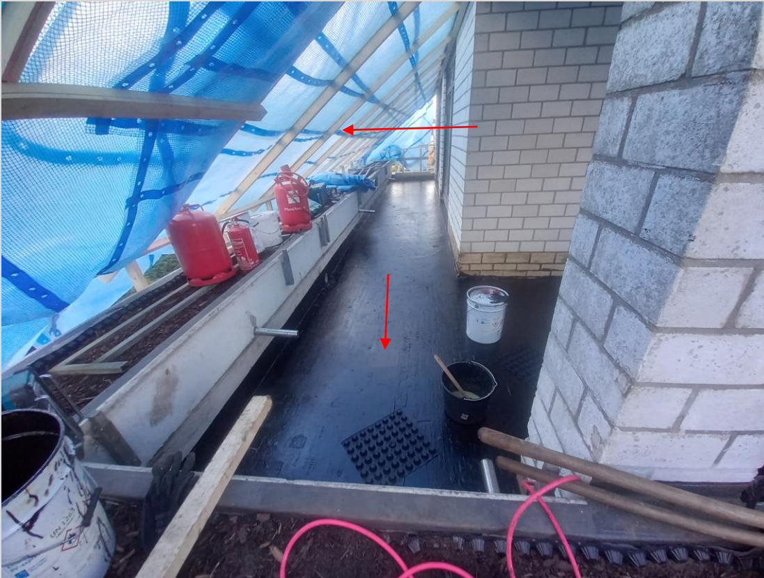
Abgeplante Dachterrasse, die Grundierung wird aufgebracht
