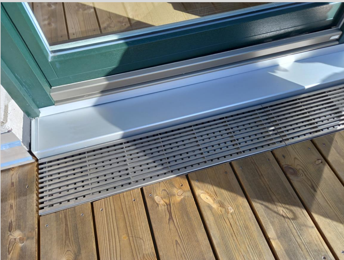
Eine Entwässerungsrinne vor den Fensterelementen
