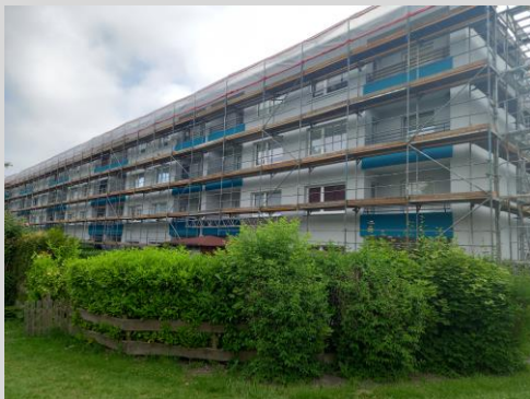
Gerüst steht immer noch
