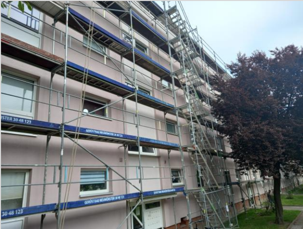
Neu eingerüstete Ostfassade
