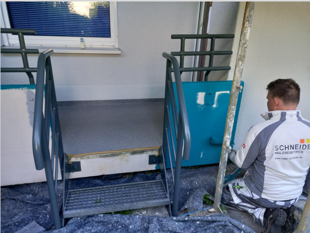
Restliche Arbeiten auf der Westseite
