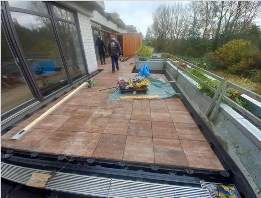
Verlegung des Dachterrassenbelages
