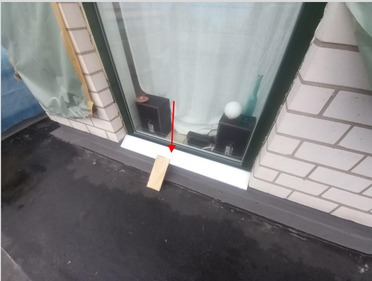
Die Fenstersohlbänke werden montiert
