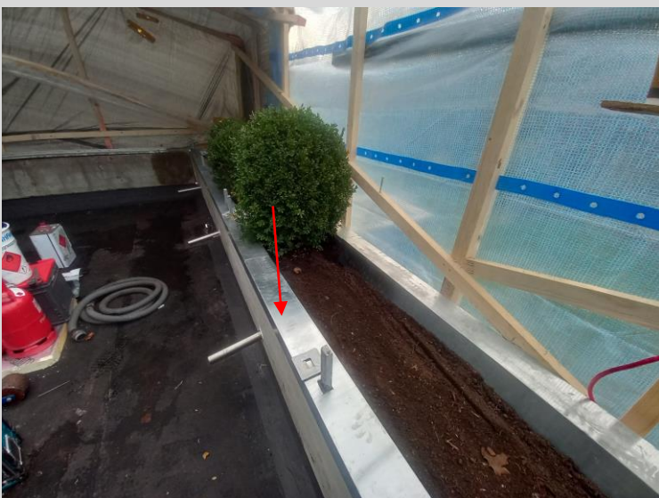
Die Zinkabdeckung wird montiert
