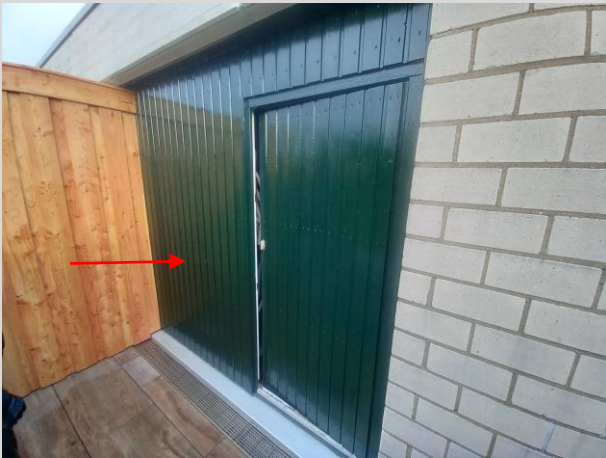
Die Holzwand inkl. Tür wurden neu lackiert
