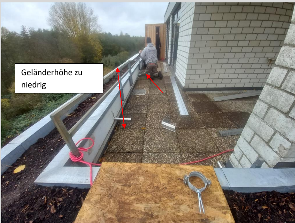
Die Trittschutzbleche werden montiert
