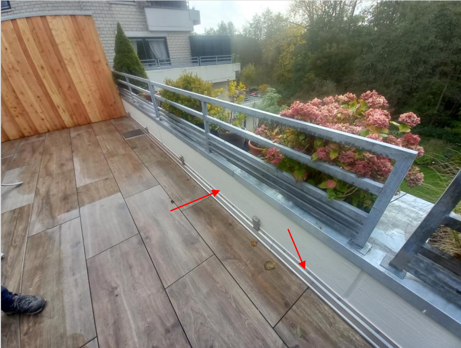
Die Brüstung wurde gestrichen, das Trittschutzprofil versiegelt
