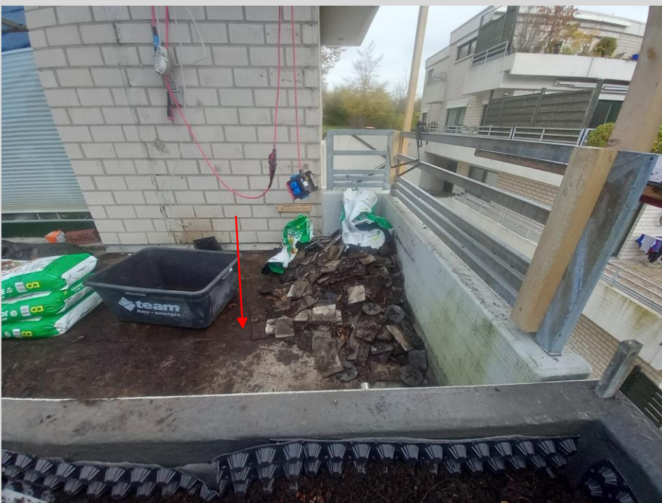
Der alte Dachterrassenbelag wurde aufgenommen
