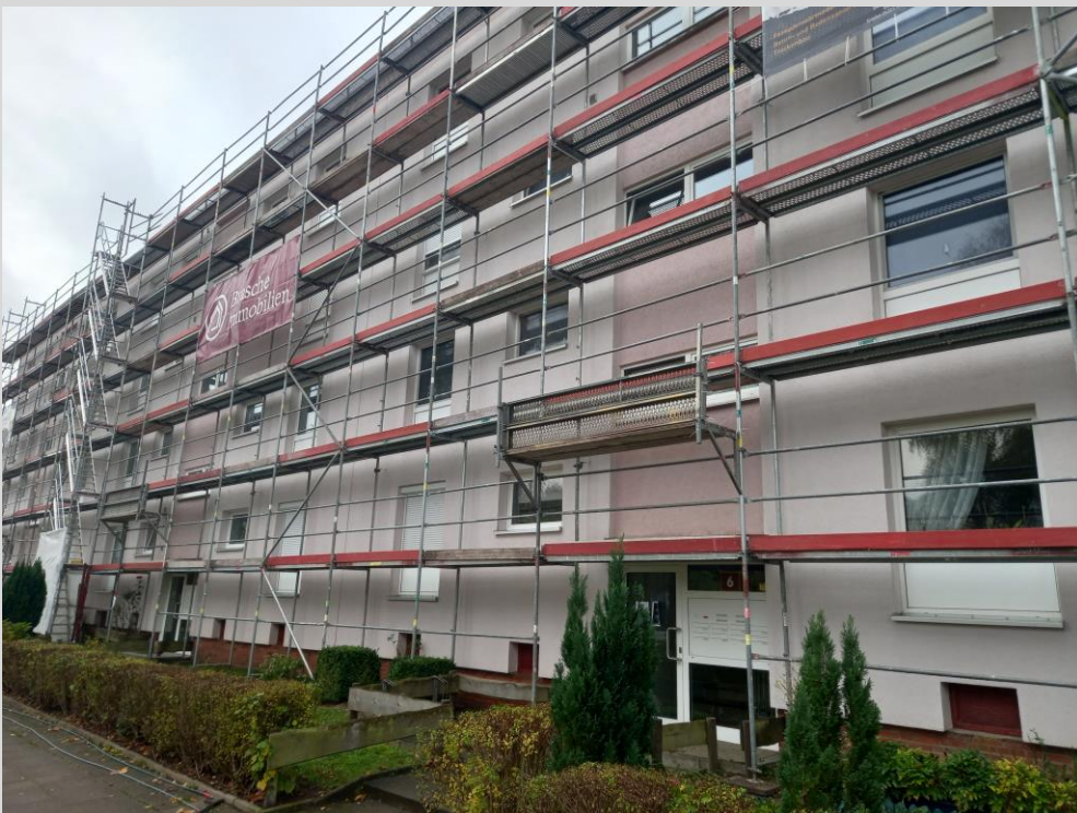
Die gereinigte Ostfassade wird mit fungizider Lösung behandelt
