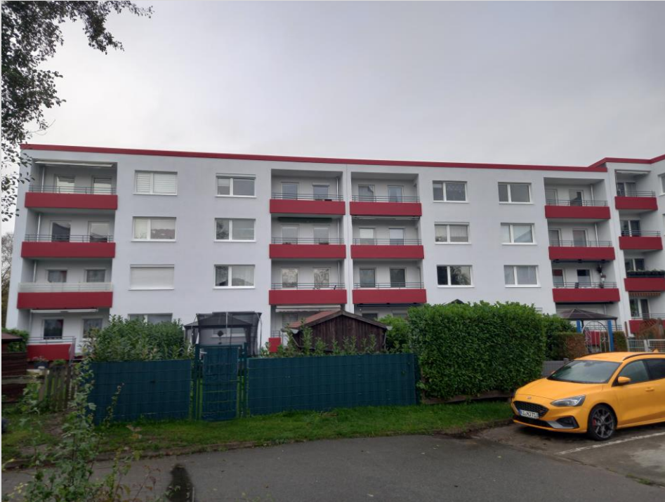
Die Südfassade ist abgerüstet
