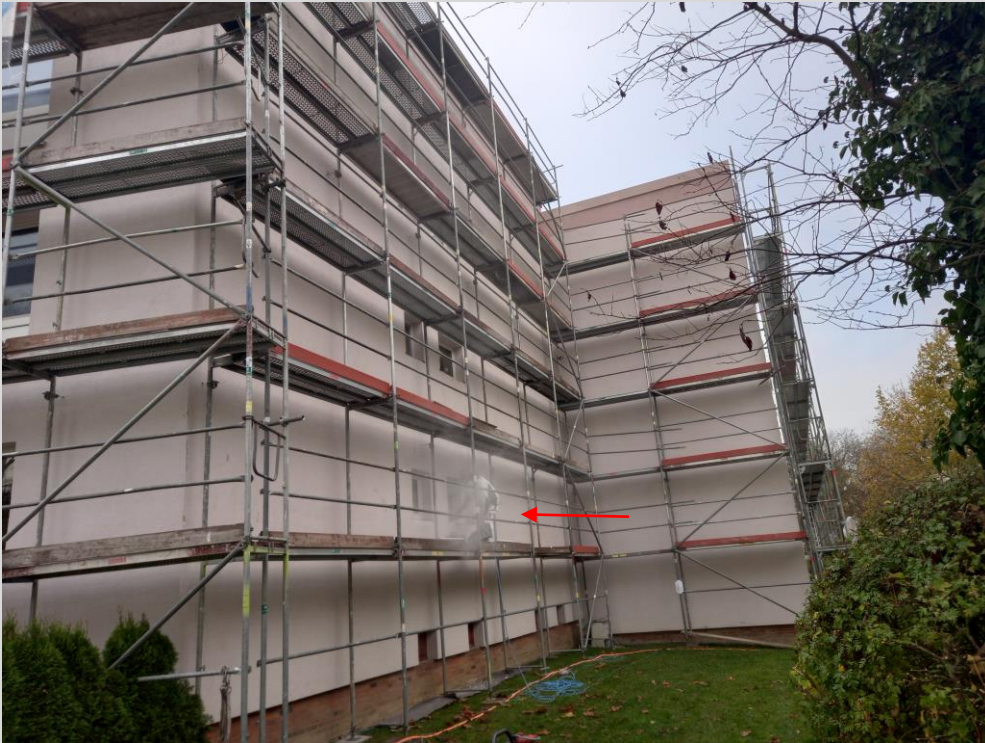
Fensterbänke werden demontiert
