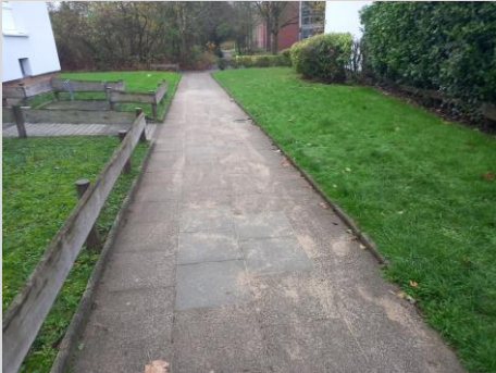
Der Fußweg wurde ausgebessert
