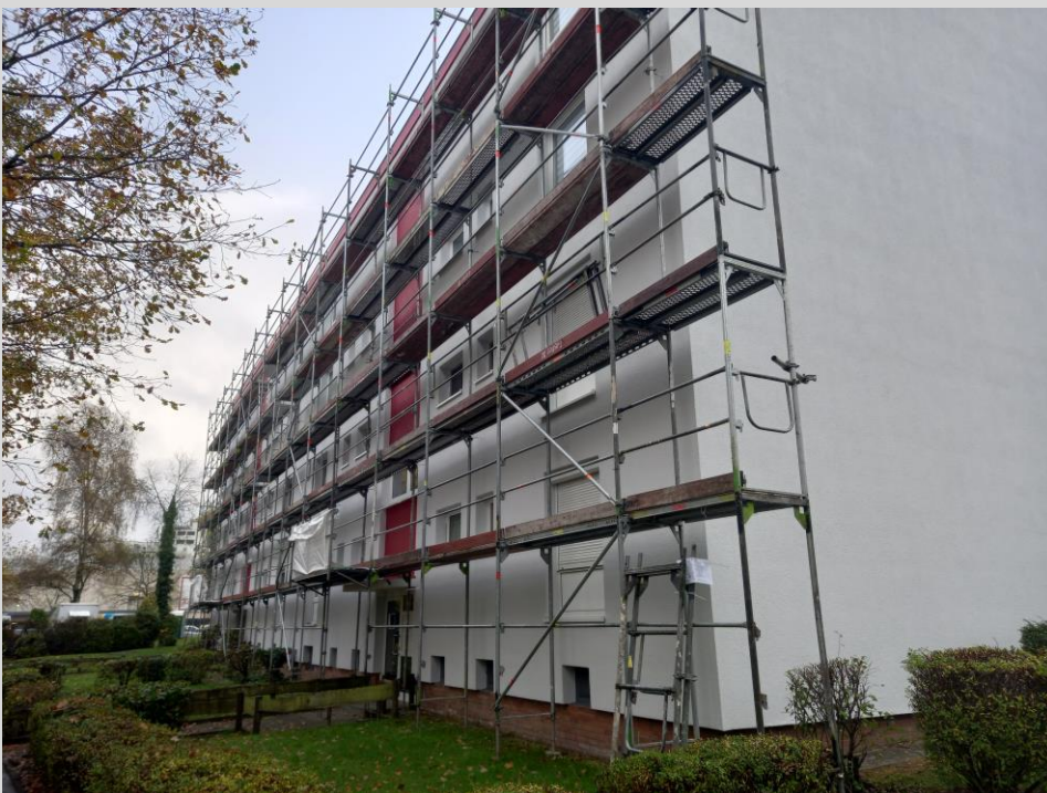
Die Nordfassade wird heute abgerüstet
