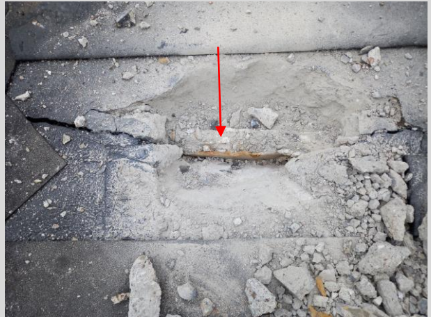
Trennfuge aus Dämmmaterial
