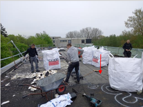
Neue Dampfsperrbahn wird in Abschnitten verlegt
