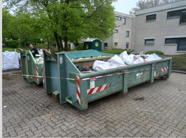
Entsorgung des abgetragenen alten Dachbelages
