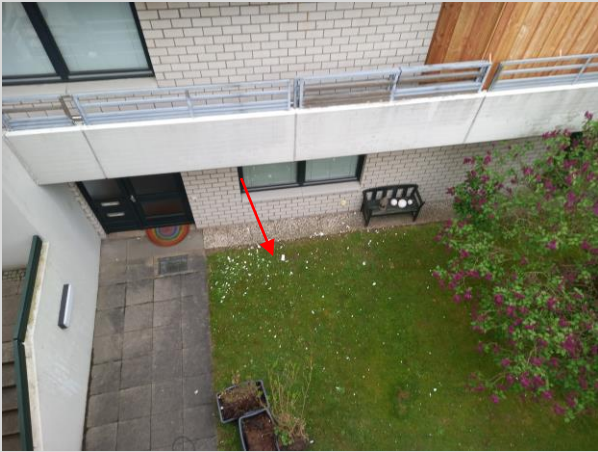
Materialreste durch Abbrucharbeiten entfernen
