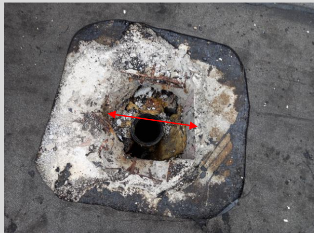
Öffnung wird um das Rohr wieder verschlossen
