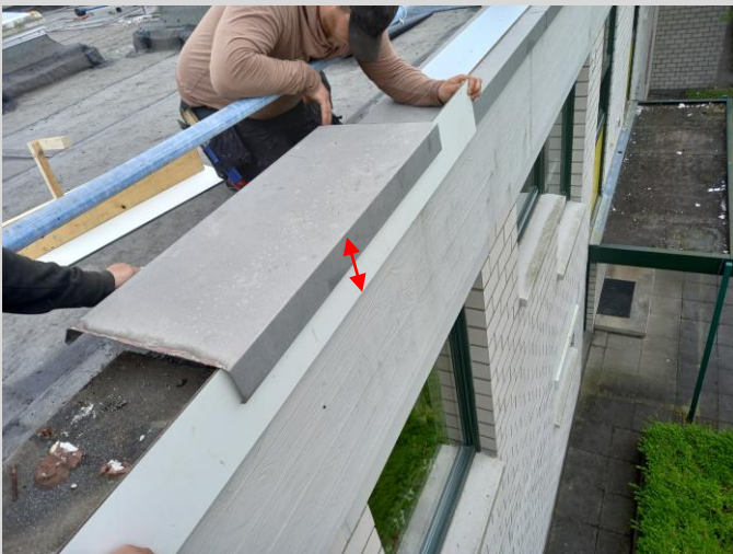
Attikablende ohne HPL-Platte/Ansichtskante Alu-Blech ca. 17,5 cm
