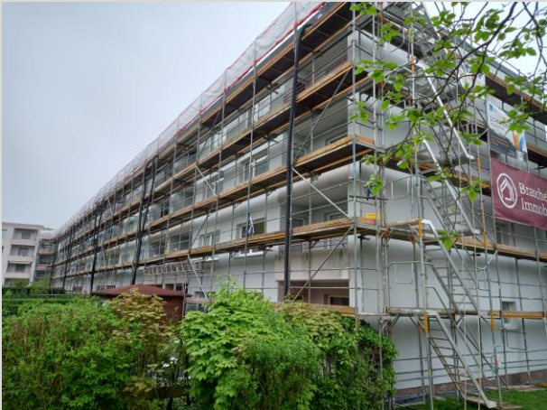
Fassadenfläche ist deckend gestrichen
