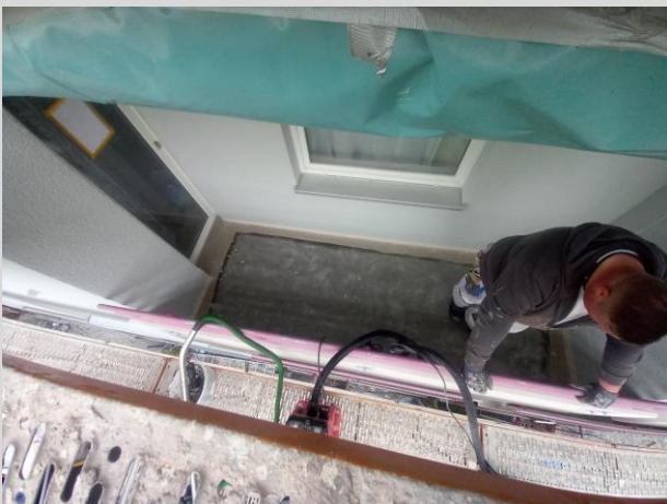
Balkonböden werden geschliffen
