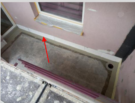
Das WDVS wird im EG ergänzt
