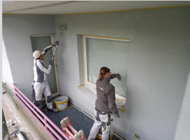
Wandflächen auf den Balkonen werden gestrichen
