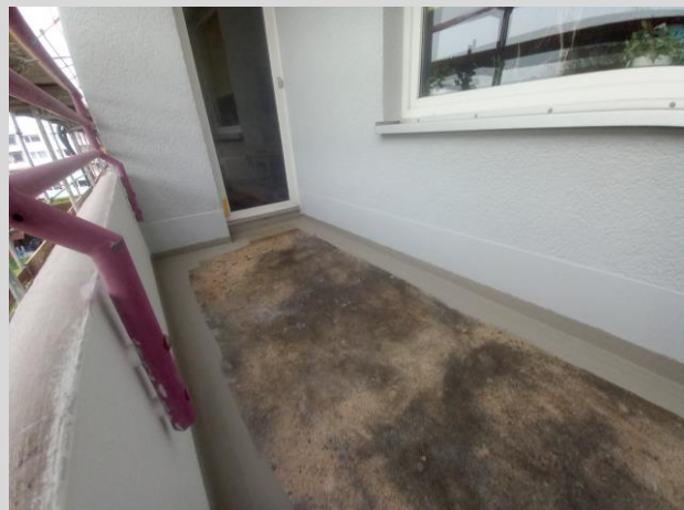
gereinigter Balkonboden ist grundiert
