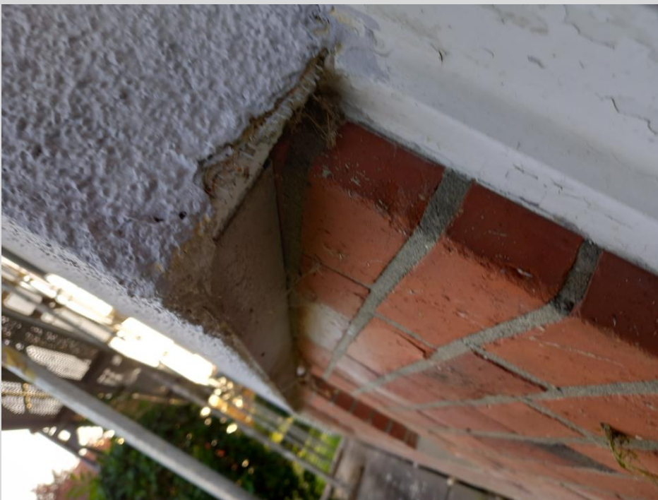
Die Eckbereiche sind zu verschließen
