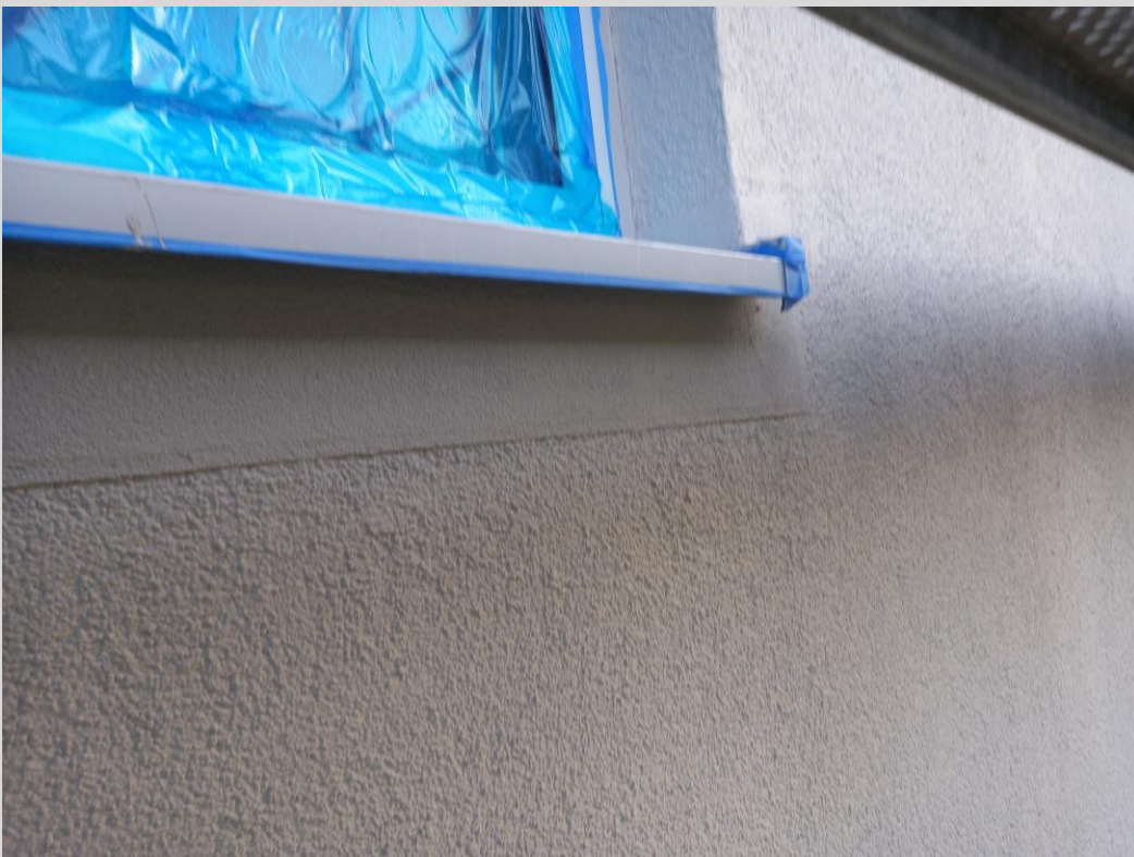
Faschen an den Sohlbänken der Südfassade fertig gestellt
