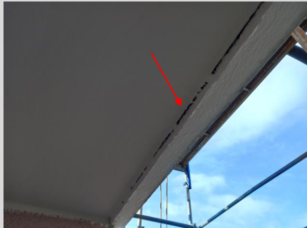
Übergang von Decke zur Brüstung wird versiegelt
