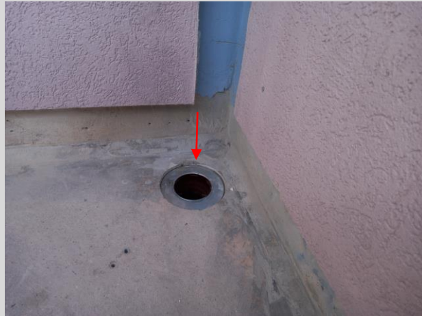
Kernbohrungen für die Einläufe werden erstellt
