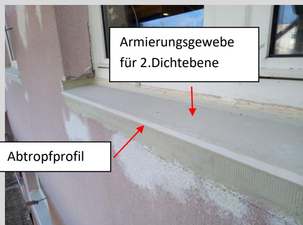
Herstellen einer 2. Dichtebene mit Abschlussprofil
