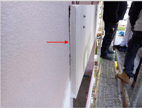
Seitliche Fuge der Brüstung wird verschlossen
