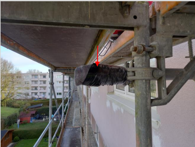
Gerüstanker wurden eingepackt
