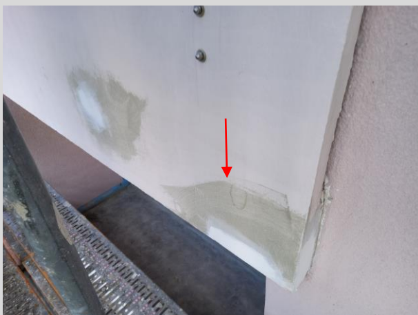
Betonschäden wurden saniert
