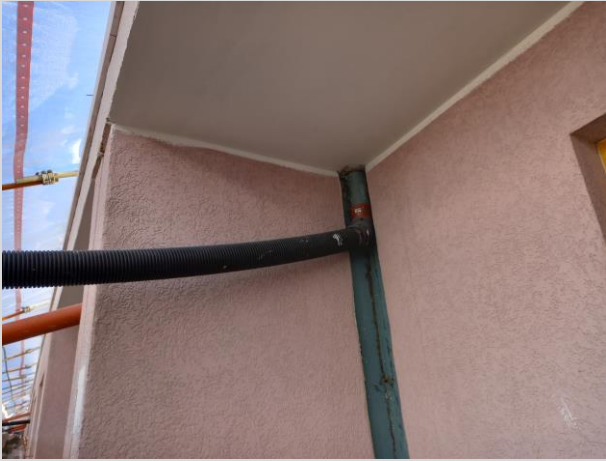
Rückbau Regenrohrleitungen und Anschluss Notentwässerung
