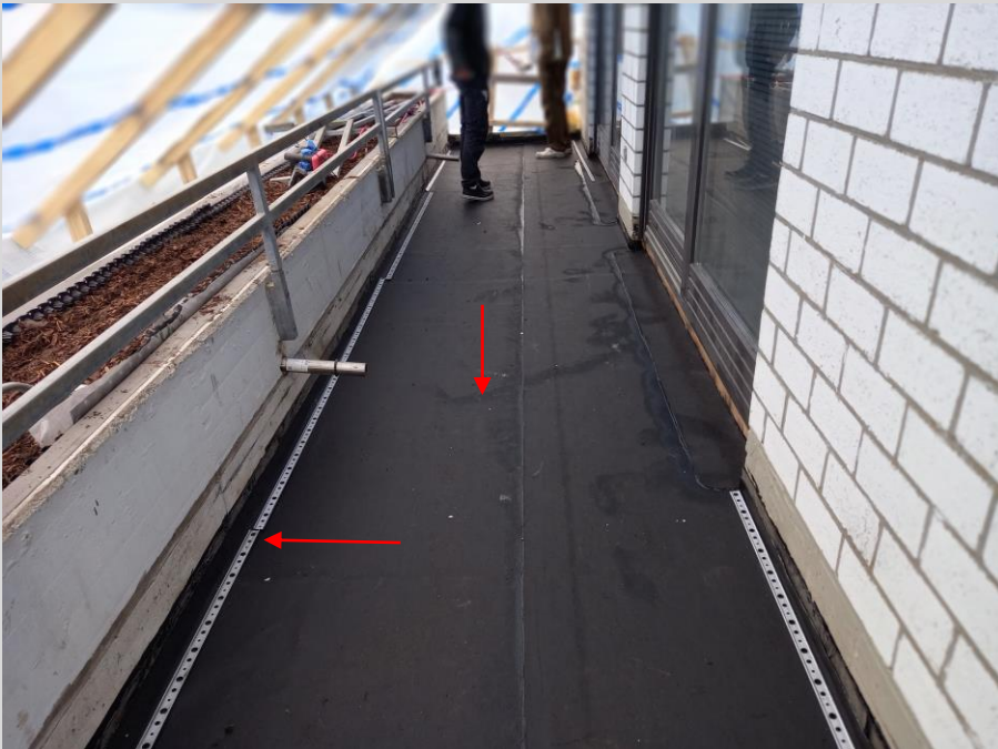
Die Oberlage ist aufgeschweißt, die Randabdichtung wird hergestellt
