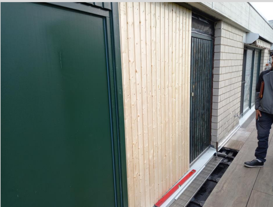
Die Wandverkleidung wird montiert
