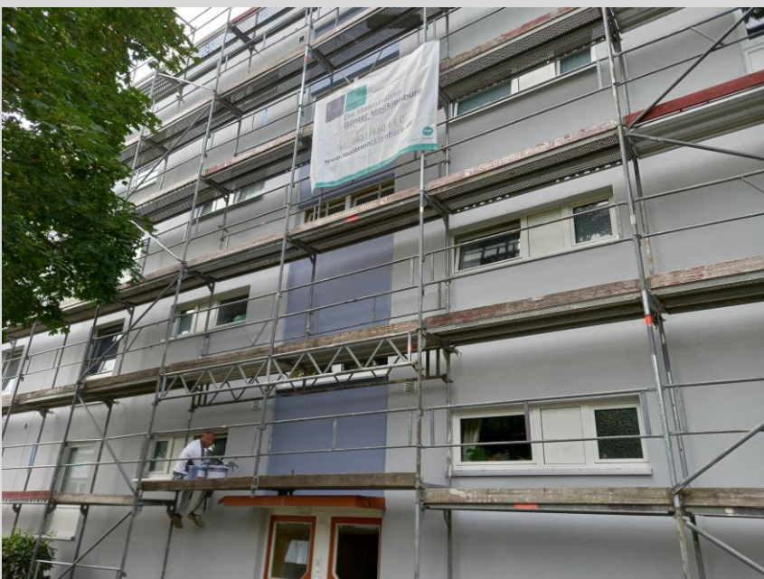
Die Nordfassade wird in dieser Woche fertig gestrichen sein
