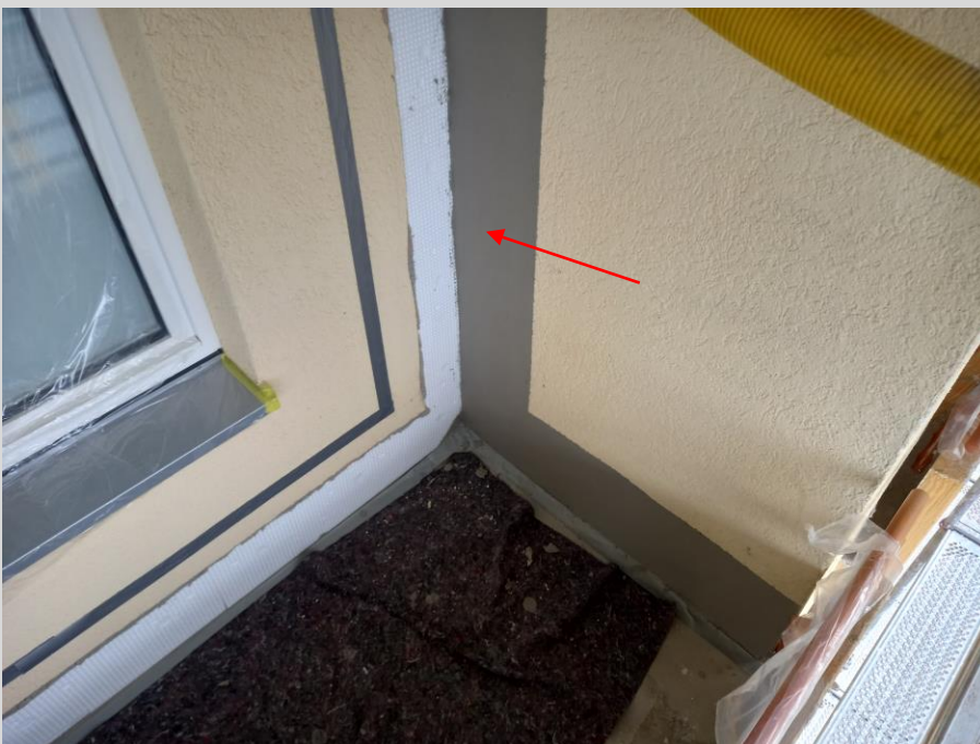
Die ergänzten Dämmplatten werden armiert
