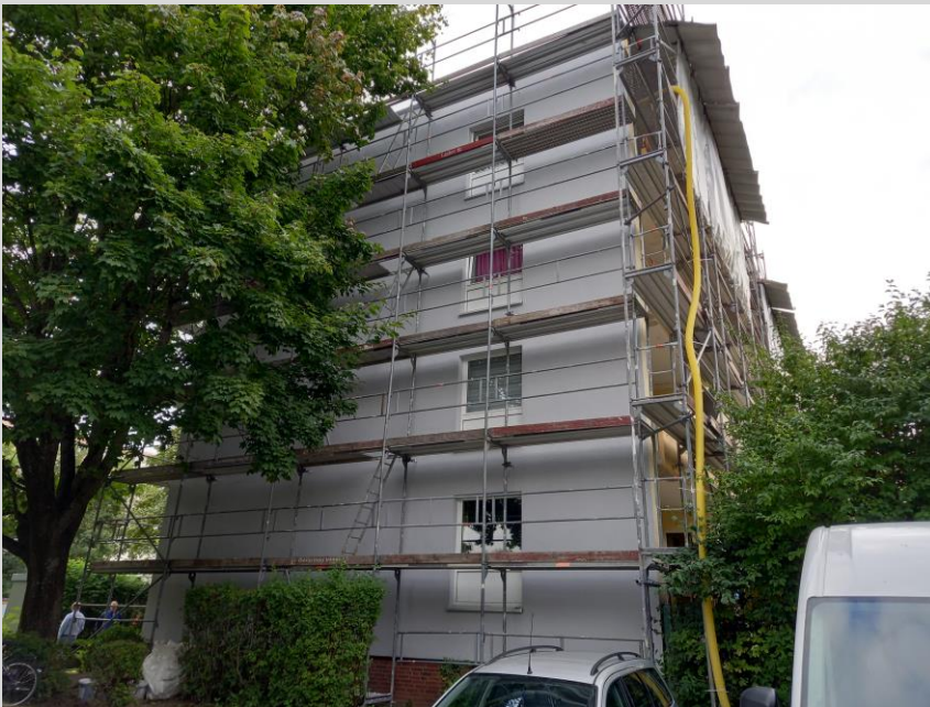
Die Westfassade ist fertig gestrichen
