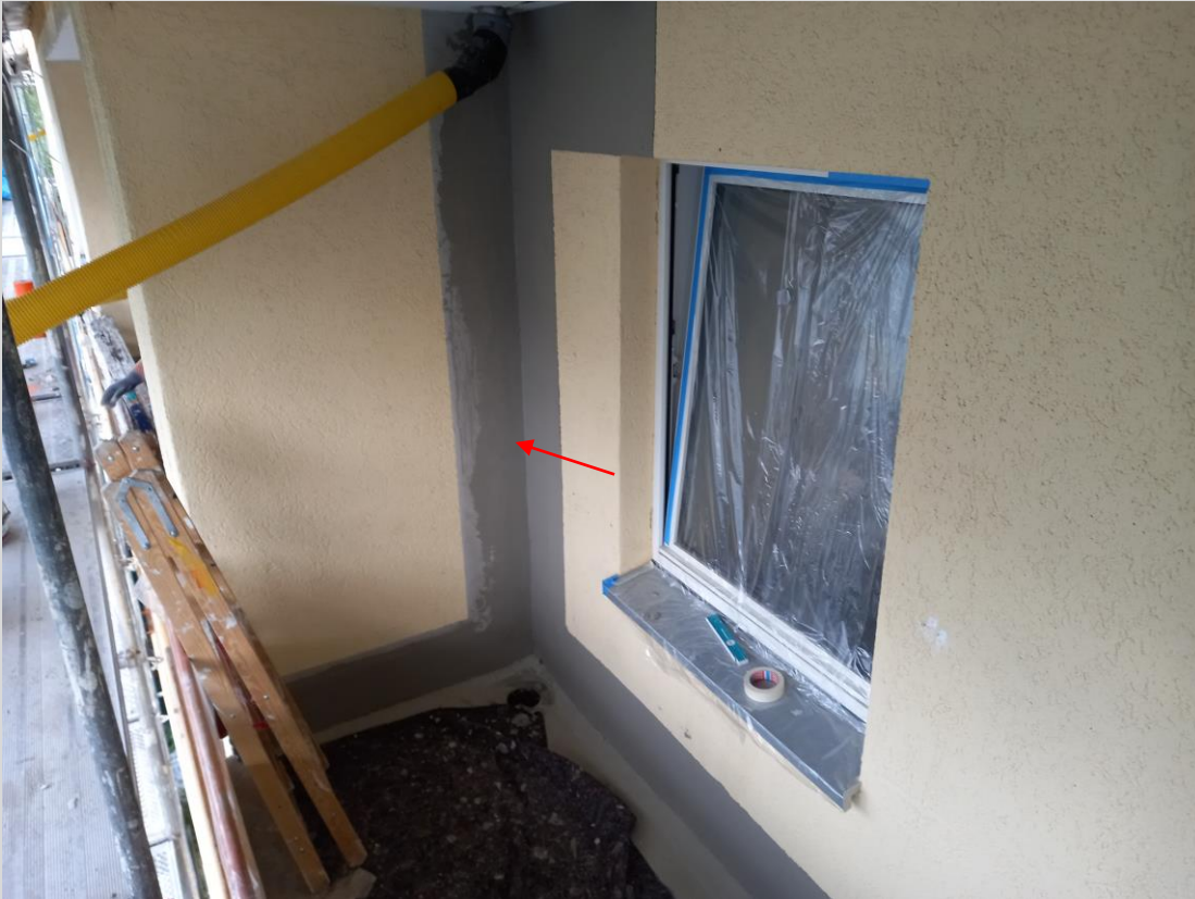
Armierung der aufgefüllten Dämmlagen
