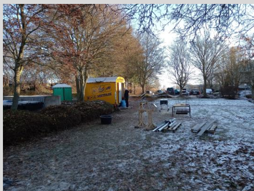
die Baustelle wird abgeräumt
