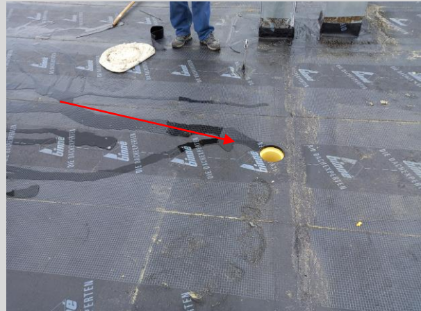
Die Gefälleführung wurde überprüft
