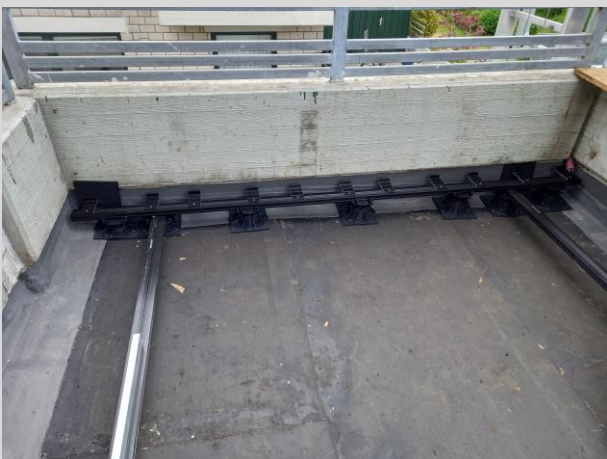
Die neue Dachterrassenunterkonstruktion wird verlegt
