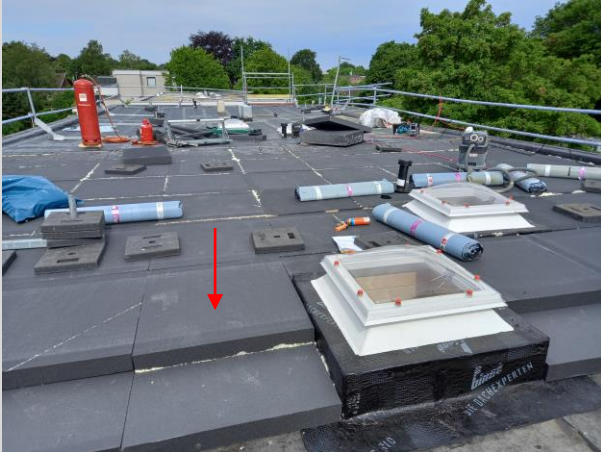
Die Gefälledämmung wird verlegt
