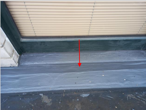
Flüssigkunststoff im Randbereich
