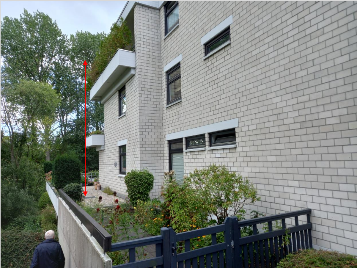
Ein Gerüstturm wird vor der Ostfassade aufgestellt
