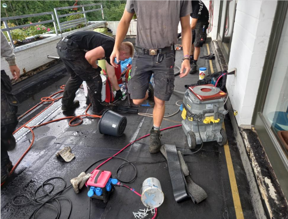
Fläche auf der Dachterrasse Juretzka ist eingedichtet worden
