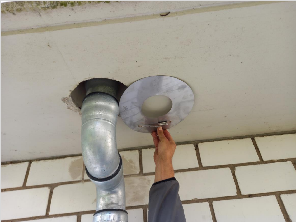
Die Rosetten dient zur Abdeckung der Kernbohröffnung
