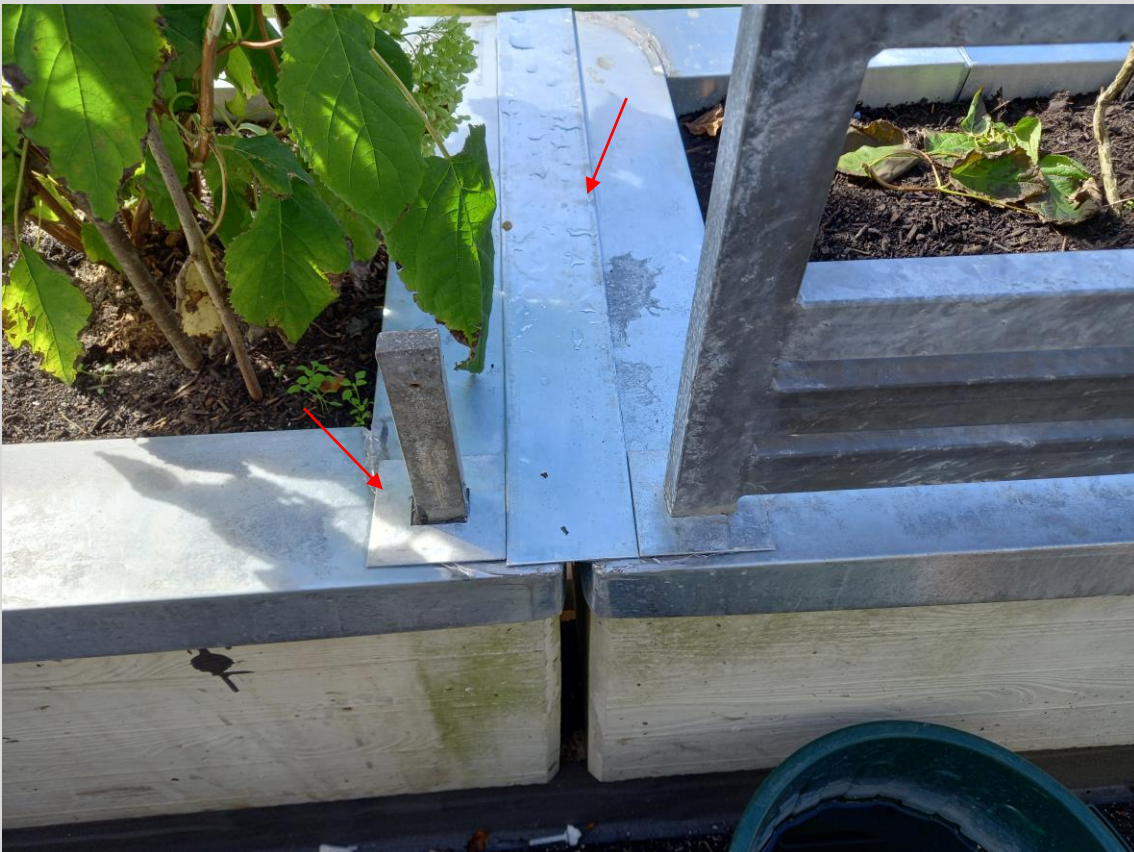
Rosetten wurden um die Geländerfüße und Abdeckbleche über den Stoßfugen montiert
