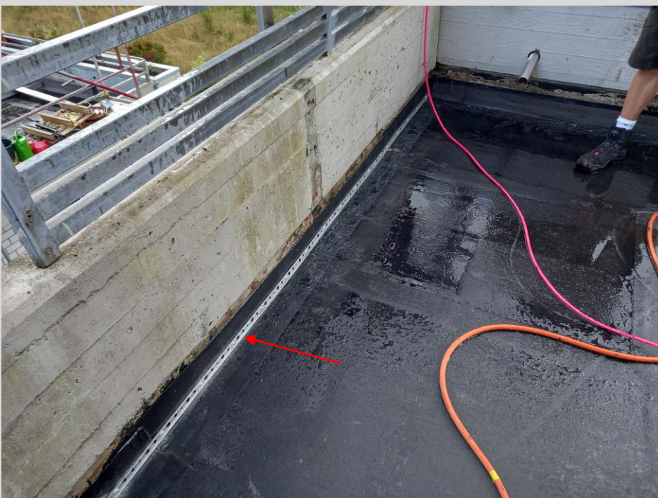
Die Randbereiche der bituminösen Abdichtungen werden zusätzlich fixiert
