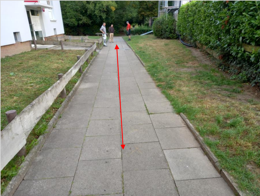
Der Abschnitt des zu reparierenden Fußweges wurde festgelegt
