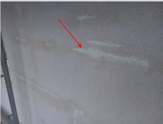
Fassadenrisse wurden verschlossen
