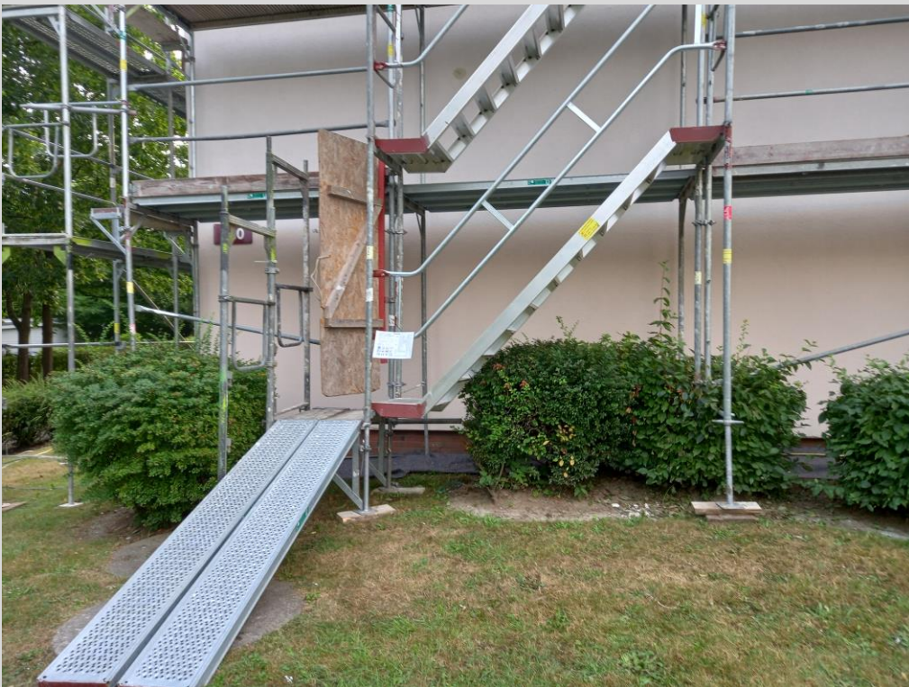
Der Zugang des Treppenturmes ist noch nicht verkleidet worden
