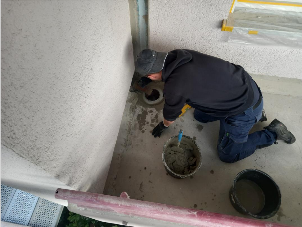
Die neuen Bodeneinläufe werden eingebaut
