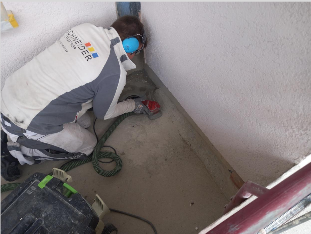
Die neu eingebauten Bodeneinläufe werden angearbeitet
