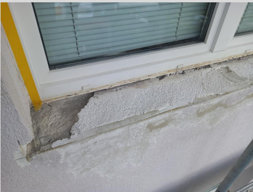
Die alten Fenstersohlbänke werden demontiert
