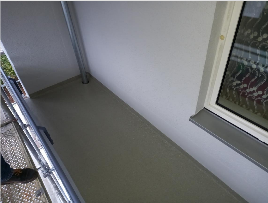
Fertig beschichteter Balkon
