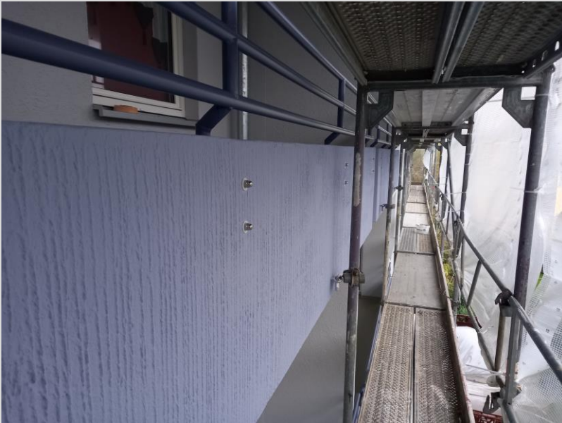
Brüstung und Geländer sind gestrichen
