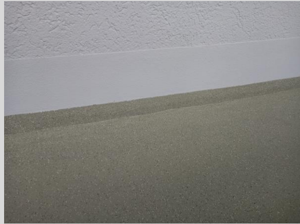
Wandanschluss wieder fachgerecht hergestellt
