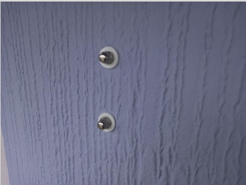
Neue Geländerbefestigung
