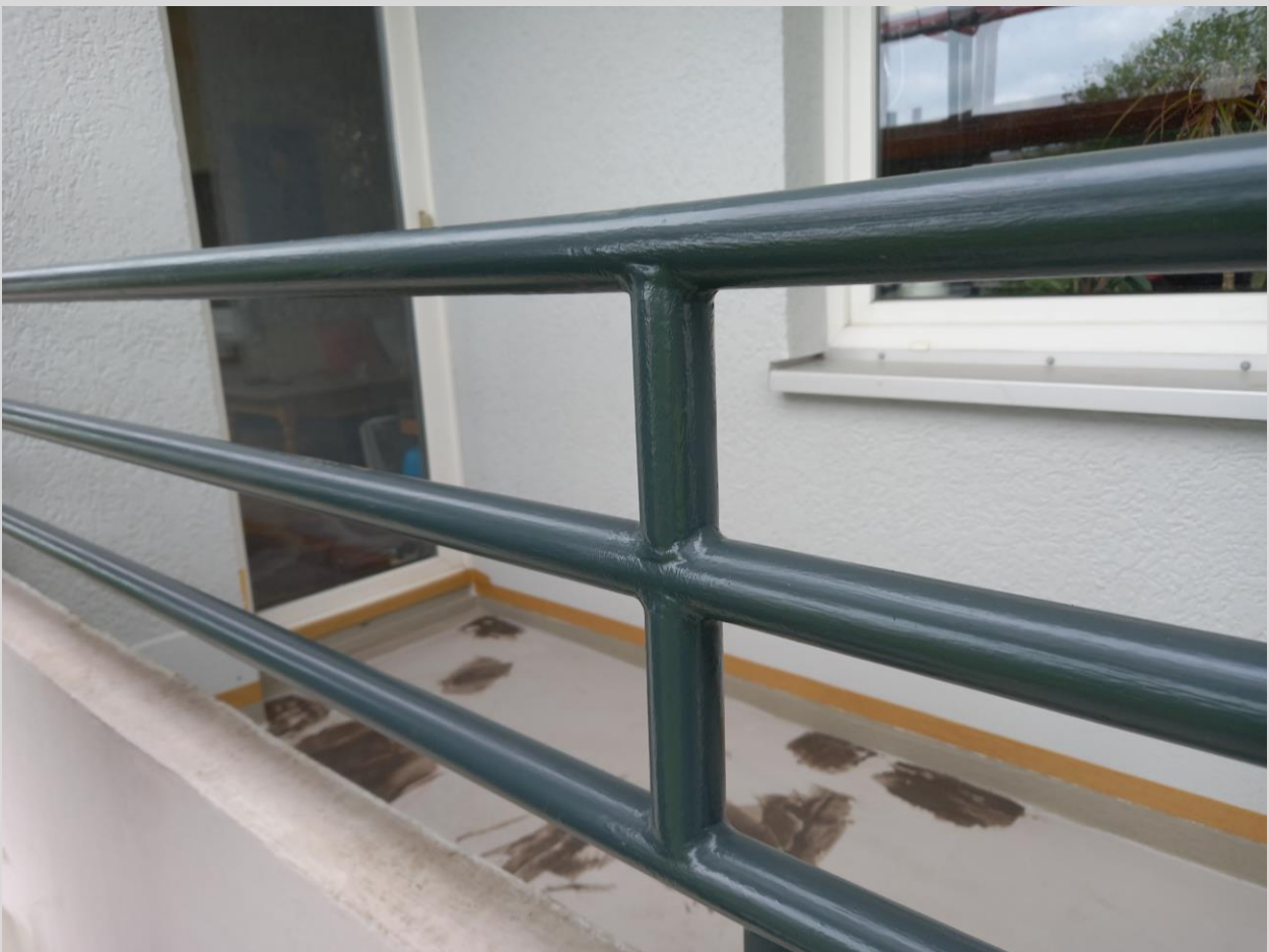
Erster Farbanstrich Balkongeländer
