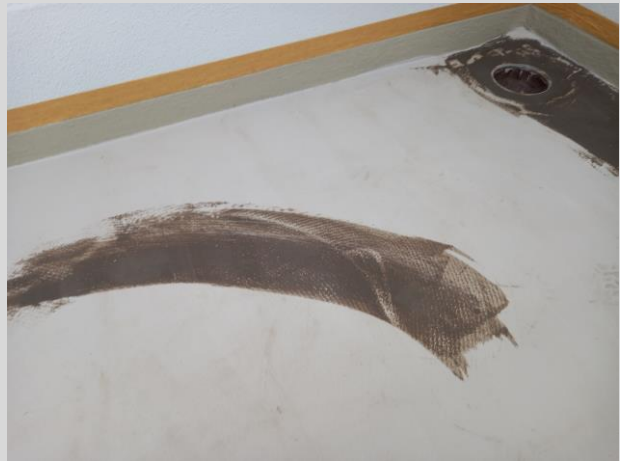
Unebenheiten werden noch beigespachtelt
