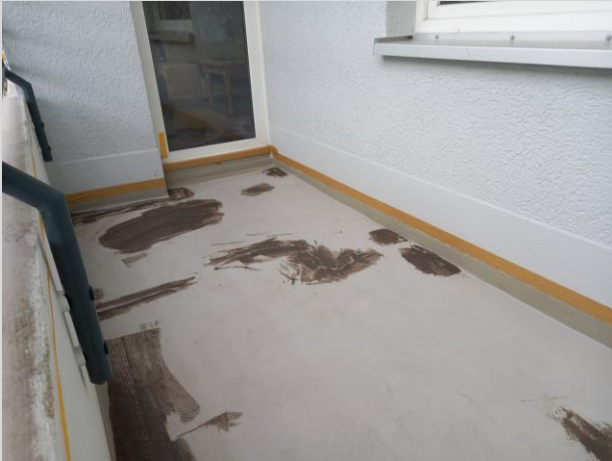
Die Dickbeschichtung ist aufgetragen
