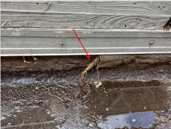
Wurzelwerk ist hinter die alte Abdichtung gedrungen Die Abdeckrosetten fehlen
