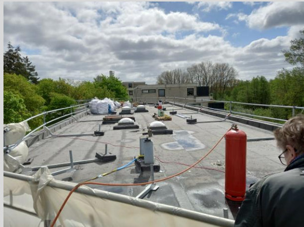
Dachfläche und Attika sind abgedichtet
