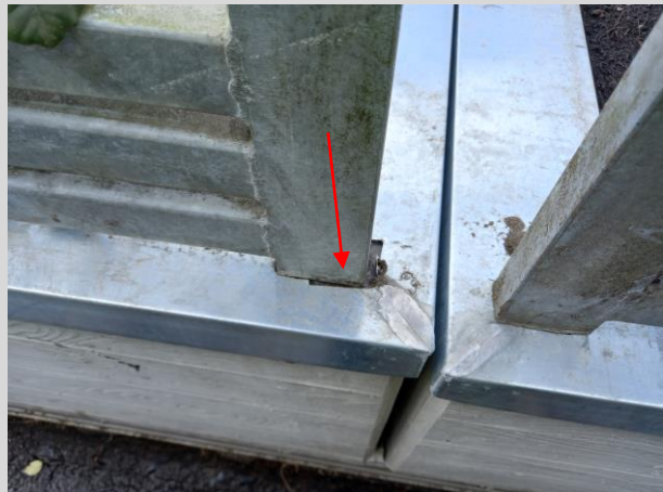
Wurzelwerk ist hinter die alte Abdichtung gedrungen Die Abdeckrosetten fehlen
