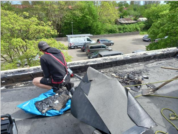
Abbruch der alten Attikablende
