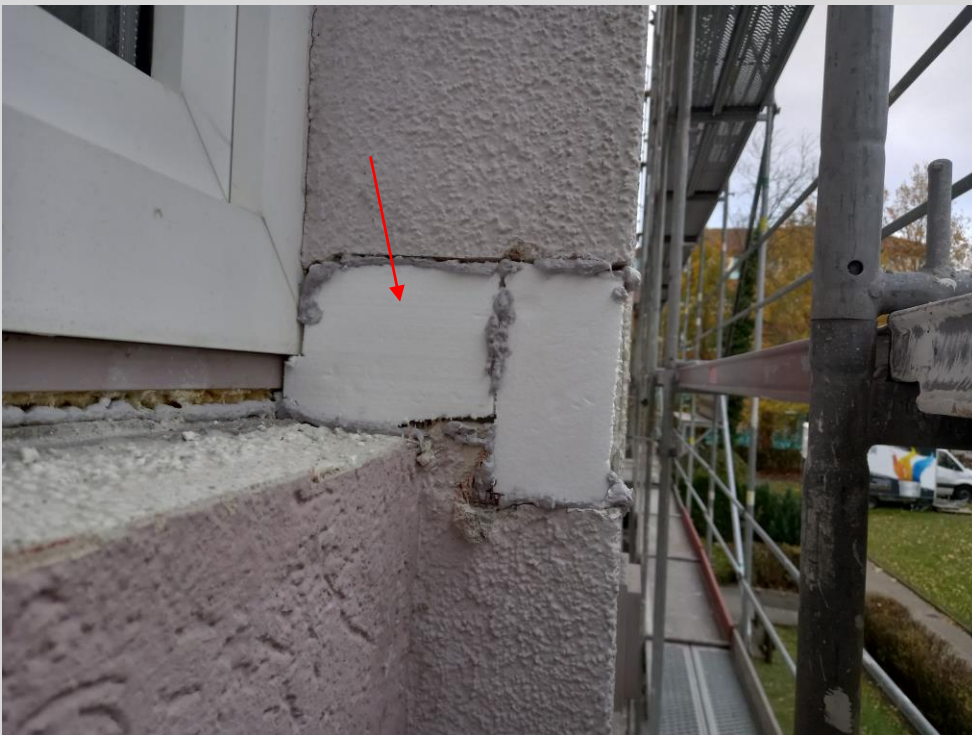
Ausbrüche und Hohlstellen werden aufgefüllt
