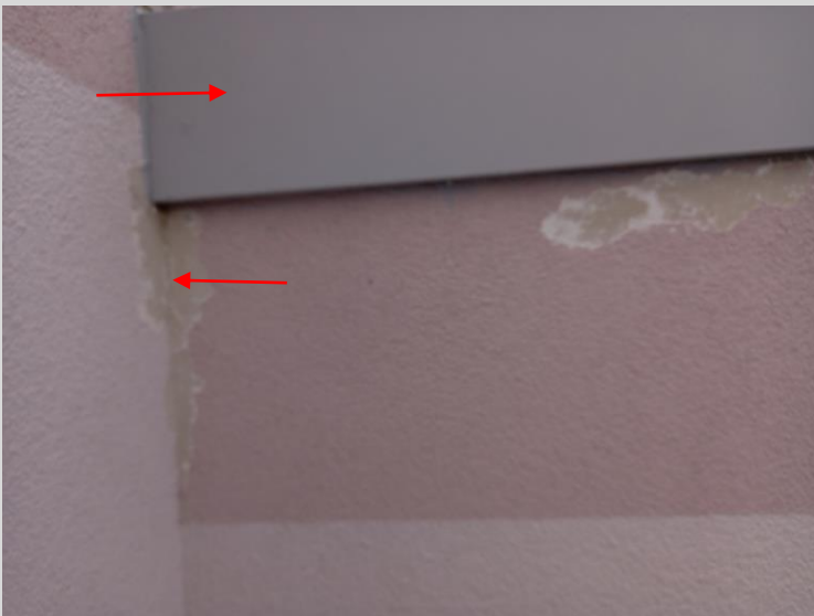
Die Attikablende ist grundiert, lose Putzflächen wurden entfernt
