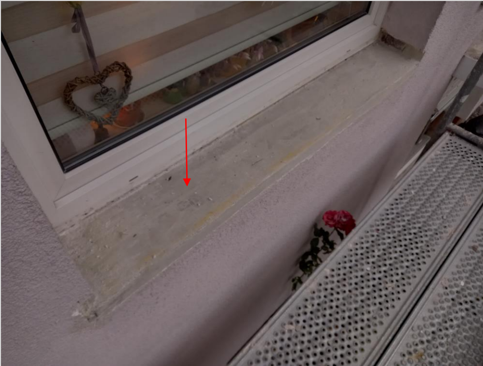
Die Sohlbankflächen sind für die Abdichtungslage vorbereitet worden
