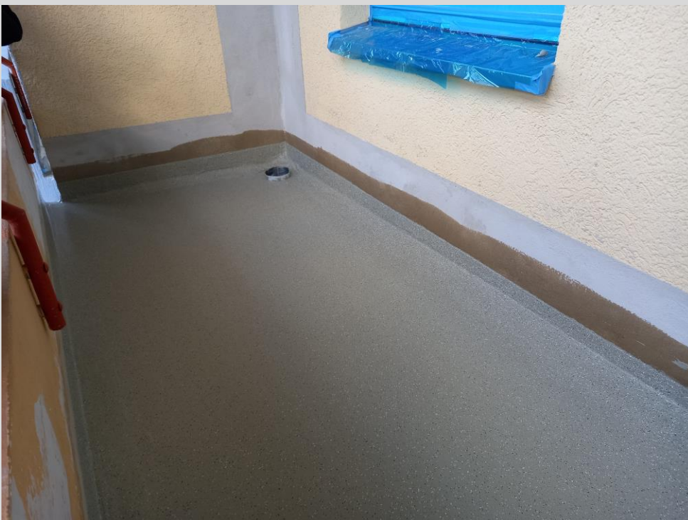
Feinputz wird in den mit WDVS ergänzten Flächen aufgetragen
