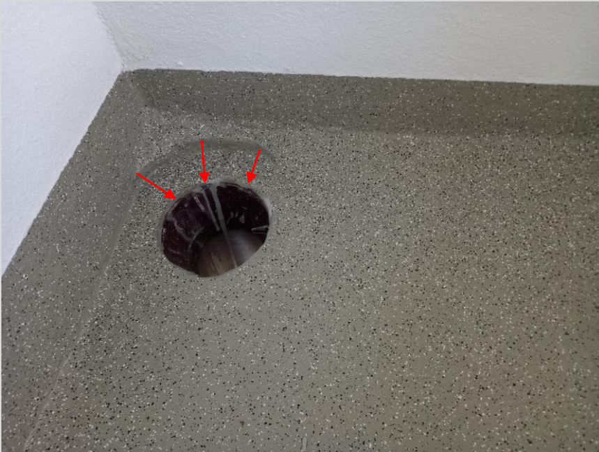
Kanten werden angespachtelt
