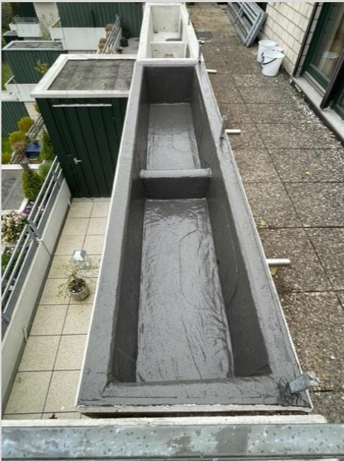
Fertig abgedichteter Pflanztrog
