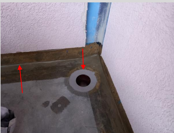
Grundieren Randbereich, einmörteln Ablauf
