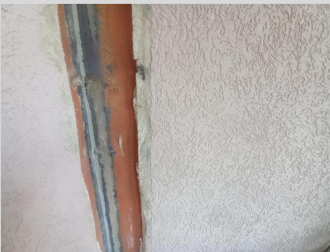
Schnittkanten werden angeschliffen
