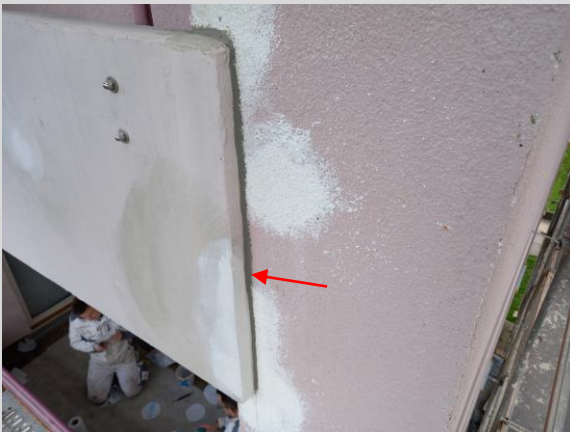
Übergänge der Brüstung an das WDVS wurde versiegelt
