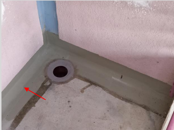
Randabdichtung ist hergestellt
