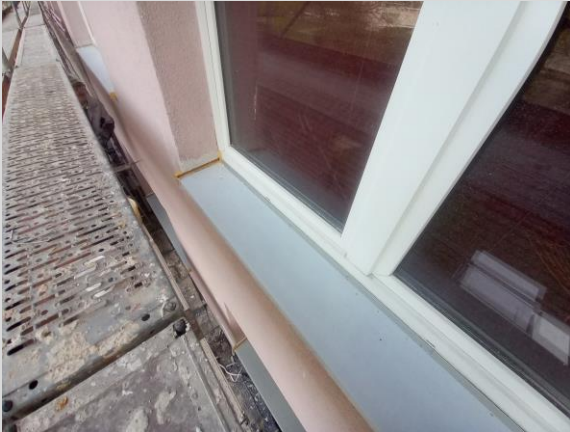
Die Fenstersohlbänke werden montiert und die Putzflächen angearbeitet
