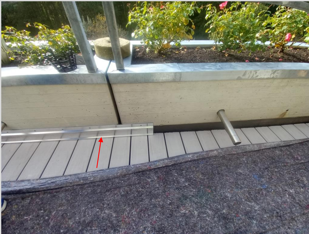
Die Trittschutzbleche werden montiert
