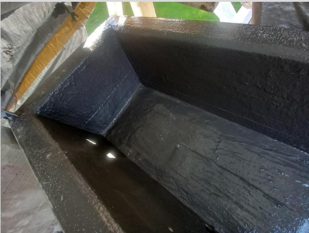
Abdichtung mit Flüssigkunststoff
