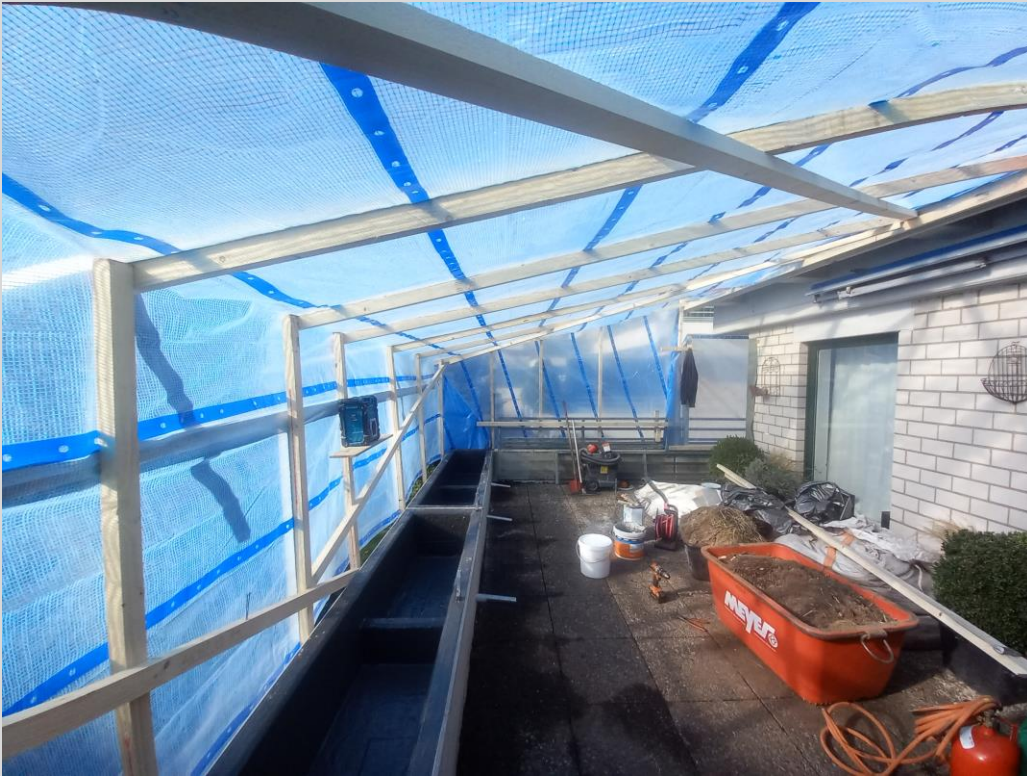
Abdichtung der Pflanztröge
