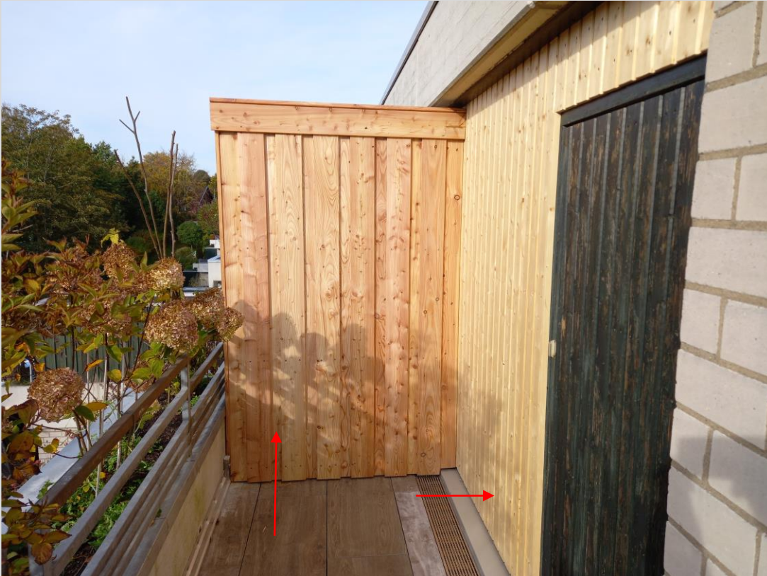
Die Trennwand zur Dachterrasse Passick und die Holzverkleidung sind fertig gestellt
