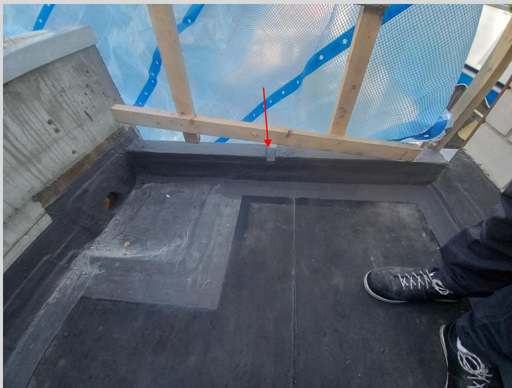
Ein Notablauf wurde in der Betonaufkantung ausgebildet
