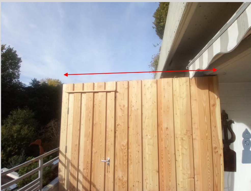
Die Zinkrandabdeckung soll heute montiert werden
