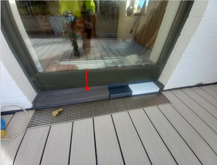
Am Freitag werden die Sohlbankbleche montiert
