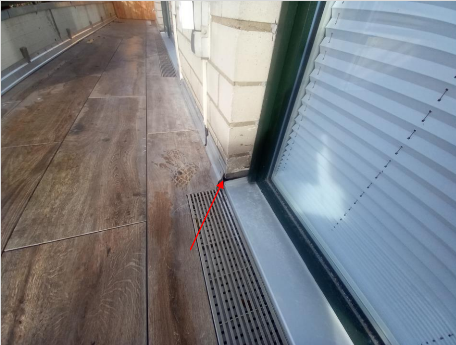
Eine Leibung wird als Musterstück mit einer Systemecke verschlossen
