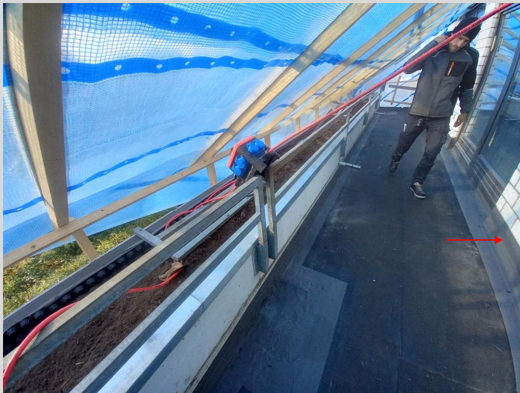
Die Randabdichtung wurde hergestellt
