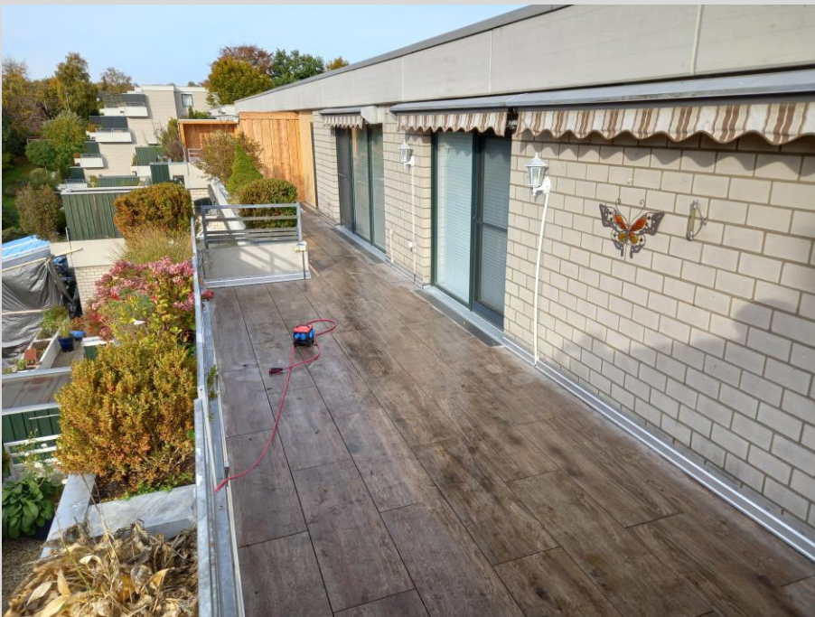
Fertig verlegter Bodenbelag auf der Dachterrasse Benthaus
