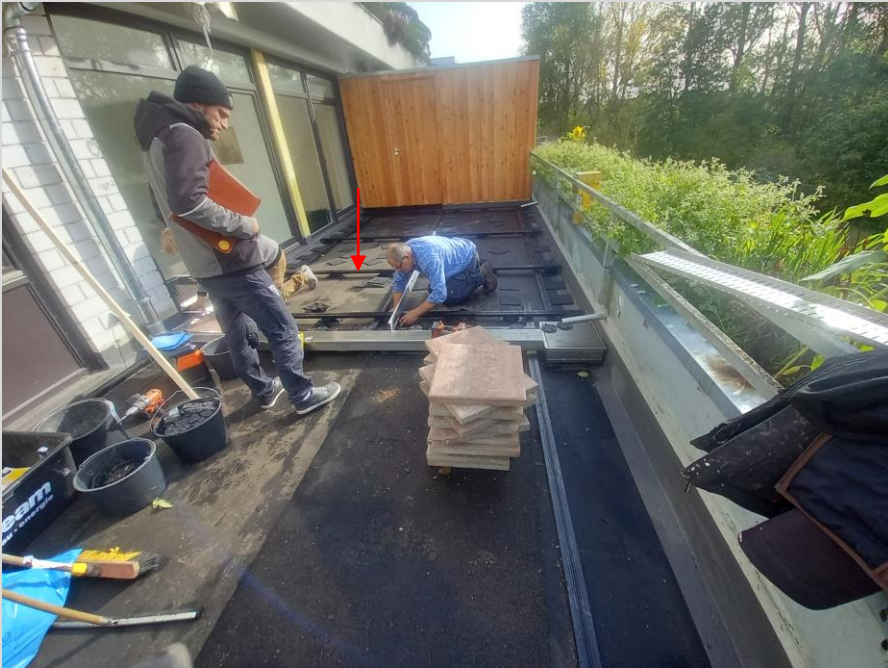
Die Unterkonstruktion für den neuen Belag wird verlegt
