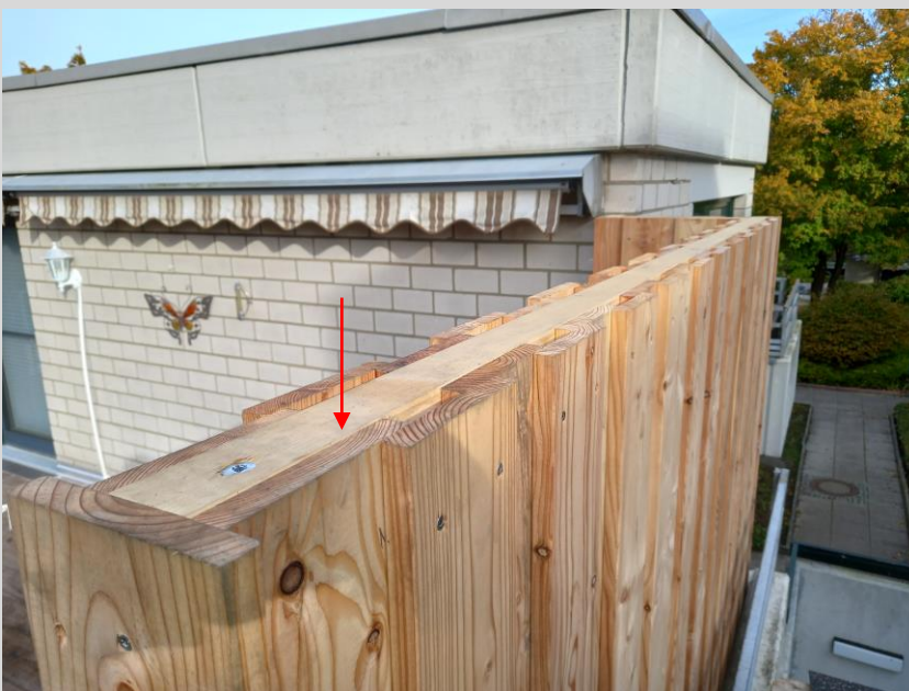
Die Sichtschutzwand erhält noch eine Zinkblechabdeckung
