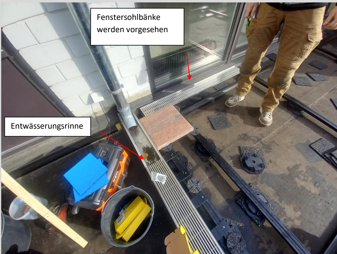
Die Entwässerungsrinne wurde aufgestellt
