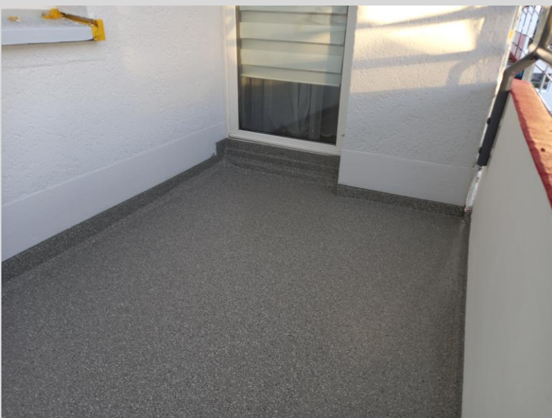
Fertig gestellte Balkonbeschichtung
