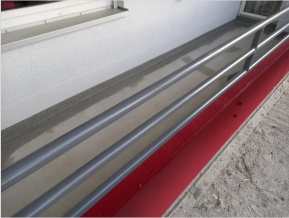
Ersten Farbanstrich Brüstung und Geländer
