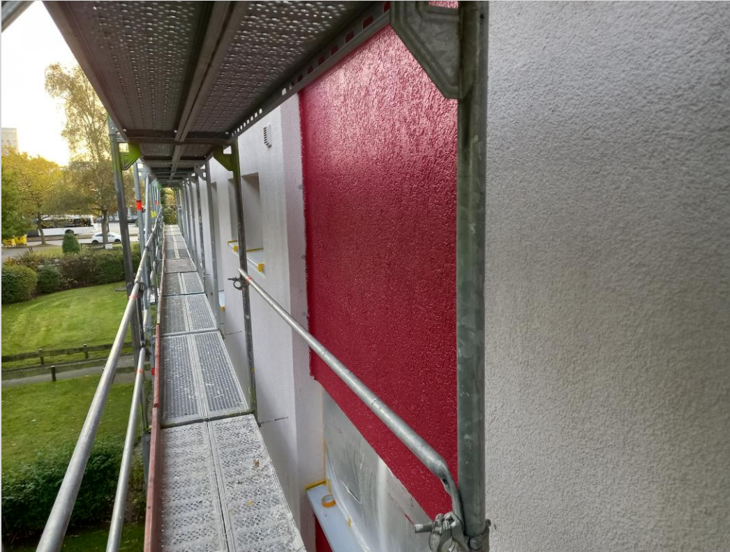
Erster Farbanstrich Nordfassade
