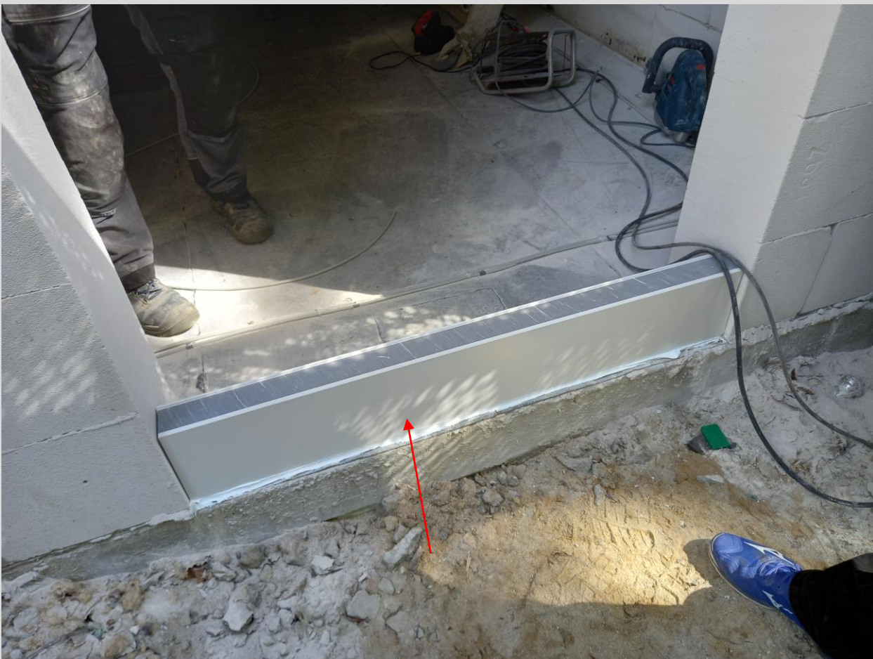
Bodeneinstandsprofile werden montiert
