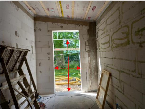
Rohbauöffnung wurde verbreitert
