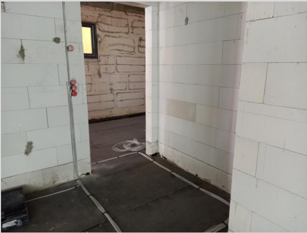
Verlegung der Kabelleitungen
