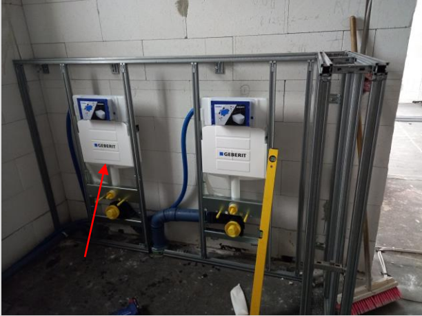
Sanblöcke sind montiert
