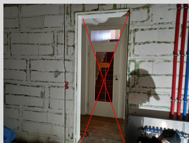
Fensterelement wurde demontiert, Bautür geplant
