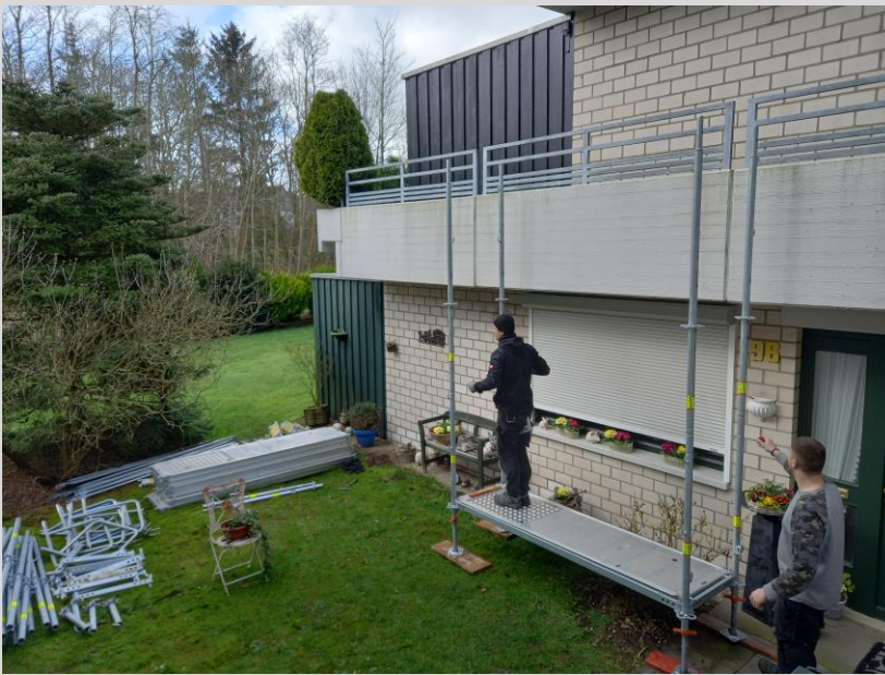
Ein Treppenturm zur Dachterrasse Kanowsky wird aufgebaut
