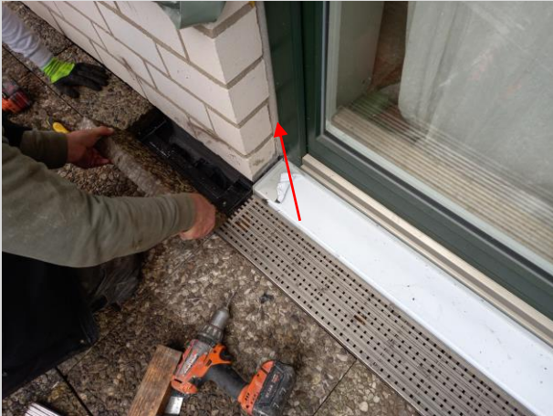
Fensteranschlüsse sind vor der Verleistung zu versiegeln
