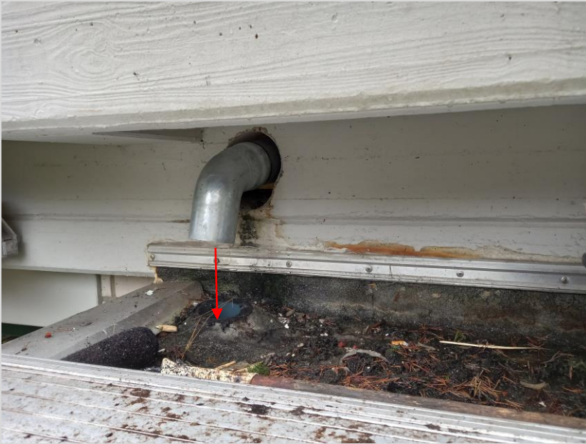
Das Entwässerungsrohr wird direkt in den Dacheinlauf geführt
