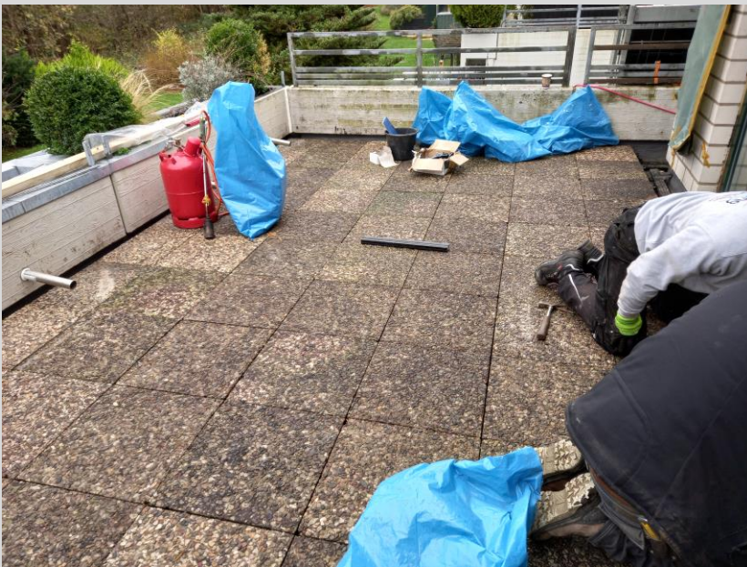
Der Dachterrassenbelag wird verlegt
