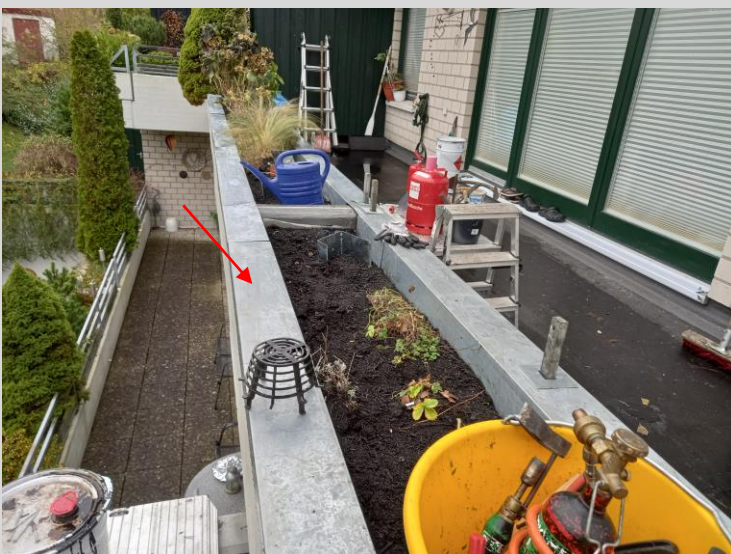
Die Randabdeckungen werden montiert
