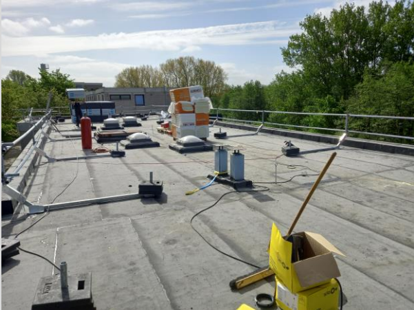
Dampfsperrbahn auf der Hauptdachfläche
