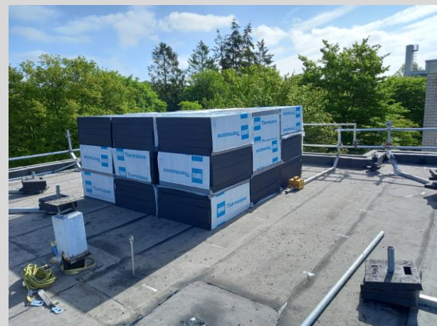
Die Gefälledämmung wurde geliefert und vertragen
