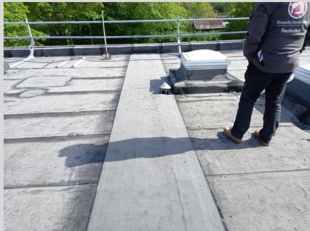
Riss in der Betondecke wurde ausgefüllt
