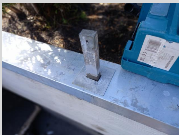
Die Zinkrosetten werden montiert
