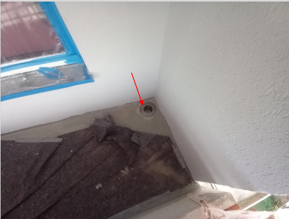
Bodeneinlauf wurde weiter in die Balkondecke eingelassen
