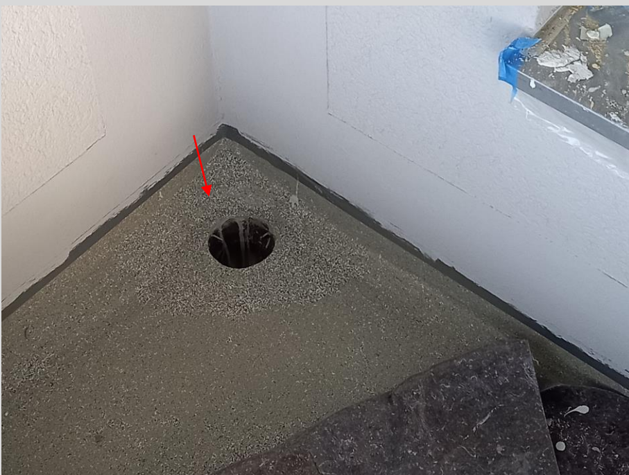
Beigespachtelte Kante um den Bodeneinlauf
