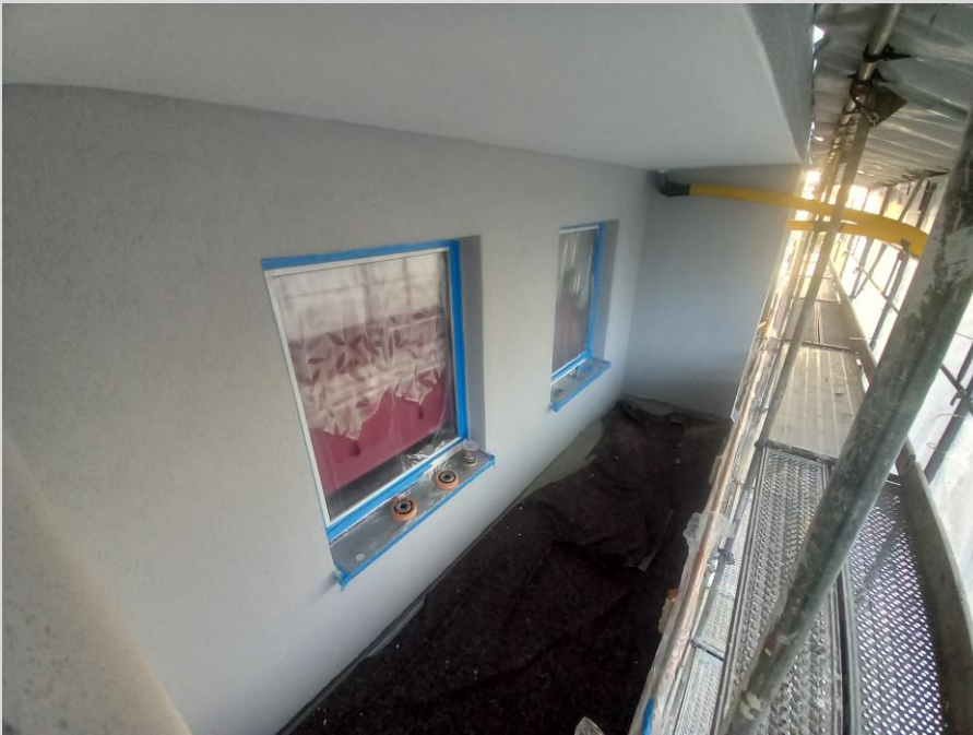
Die Wand- und Deckenflächen werden auf den Balkonen gestrichen
