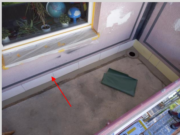
Die Randabdichtung hinter dem WDVS ist fertiggestellt, das WDVS wurde ergänzt
