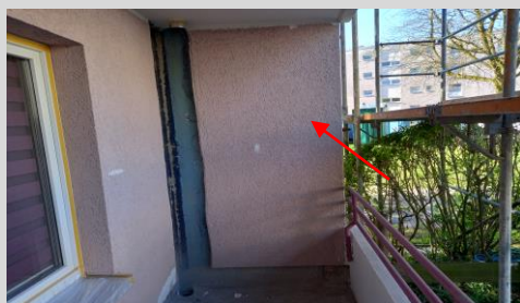
lose WDVS-Platte Balkon Nr. 120
