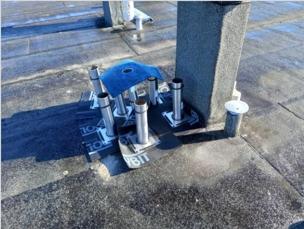
Die Dacheinläufe werden erneuert
