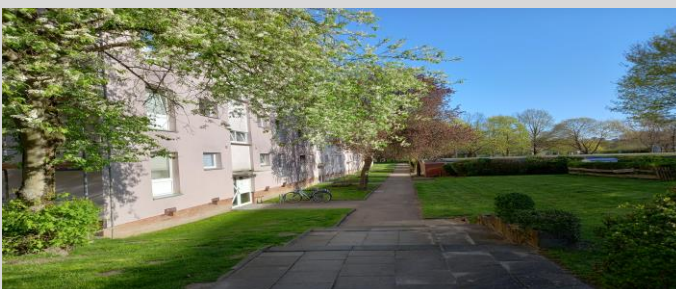
Eingangsseite wird eingerüstet
