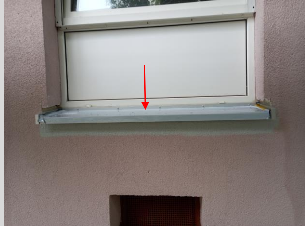
Fenstersohlbank wird eingebaut
