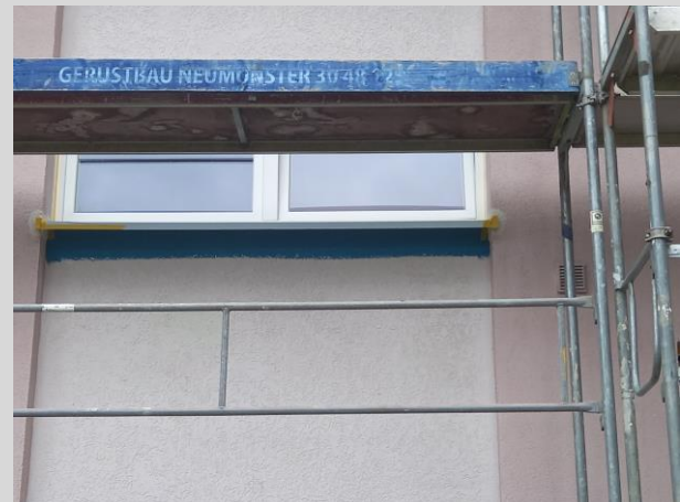
Fenstersohlbank am Treppenhausfenster
