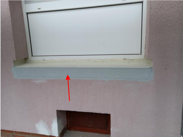
Fasche wurde hergestellt und gestrichen
