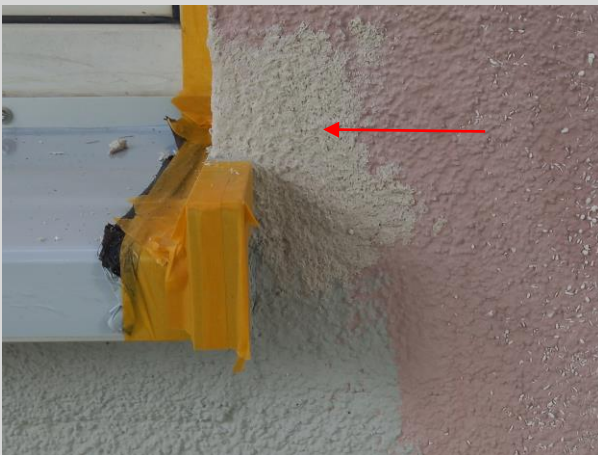
Seitliche Bereiche werden nachstrukturiert
