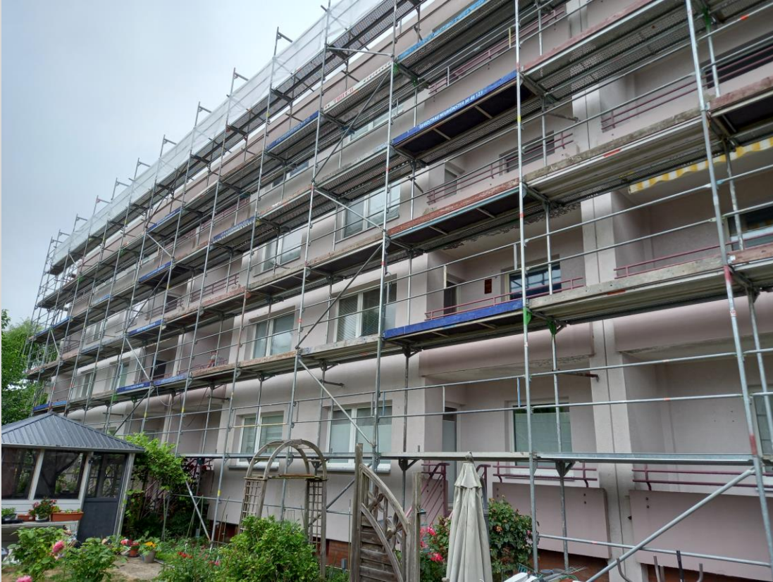
Die Südfassade und der Westgiebel sind eingerüstet, die Fassadenflächen werden gereinigt
