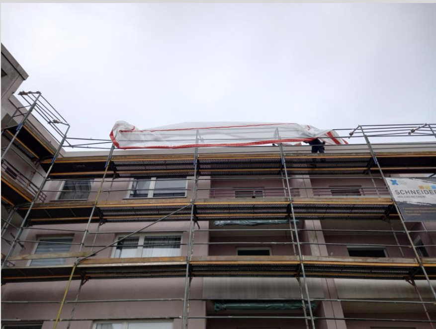
Das Wetterschutzdach wird montiert
