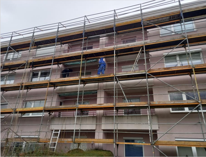
Die Fassade wird mit Hochdruckreinigern gesäubert
