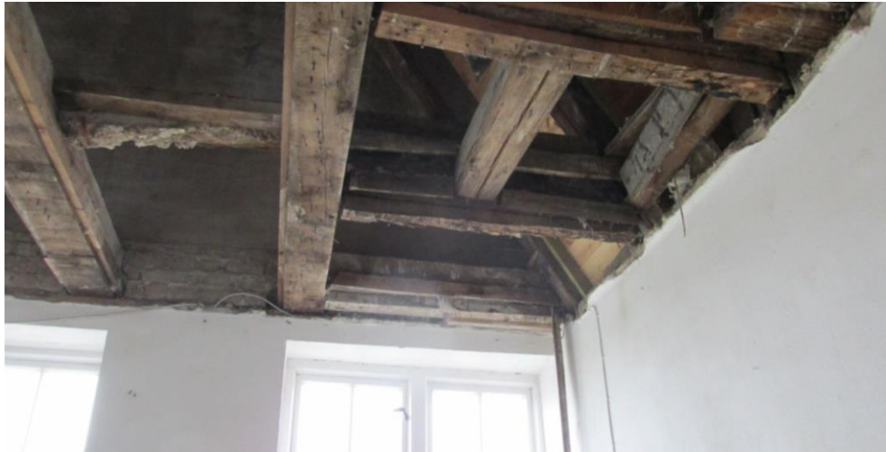
Deckenbalken 10 und 11. Prüfung wenn Einschub ausgebaut.
