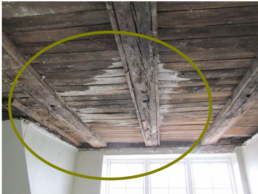
Nähere Übersicht. Gaubenzimmer Nord-West.
