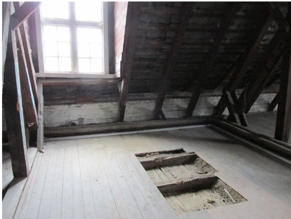
Zweites Sparrenfeld wie 1. Sparrenfeld behandeln. Deckenbalken gesundschnitten und statisch ergänzen.
