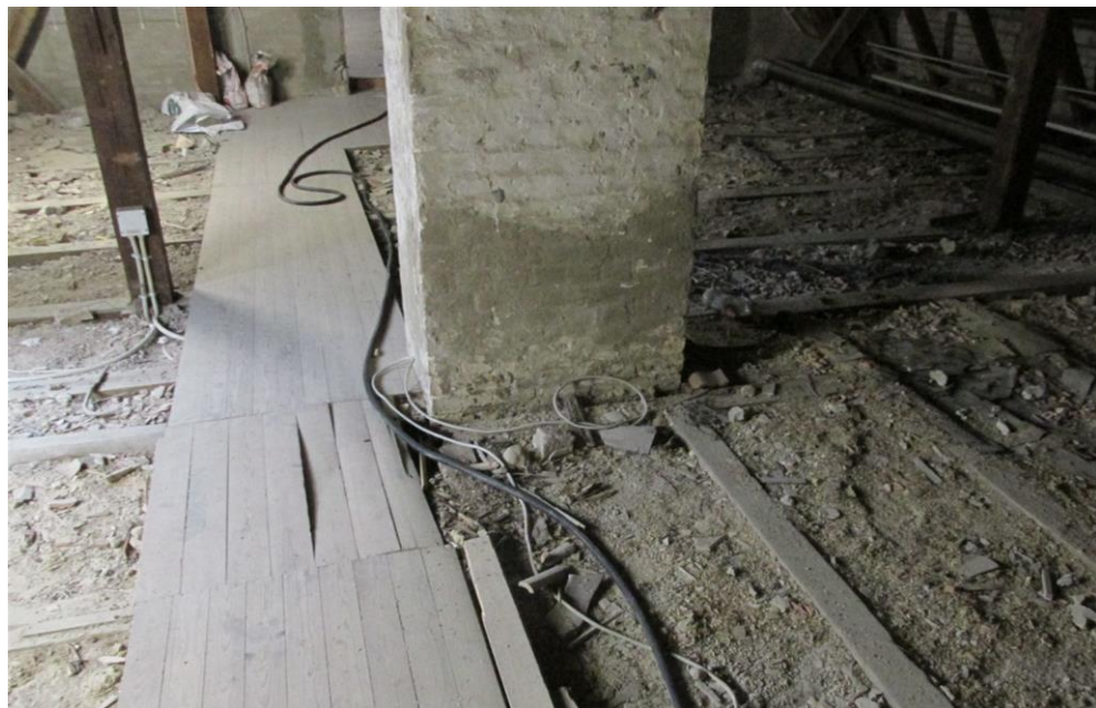
Auswechslung und Hölzer der Balkenlage freilegen. Befallene Hölzer ausbauen, gesund schneiden und neu ergänzen gemäß statischen Angaben.
