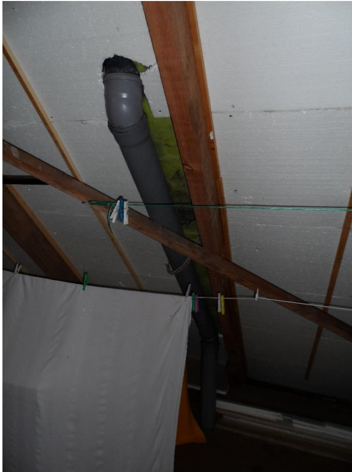
Abbildung 1: Ungedämmte Rohrleitung im Dachgeschoss
