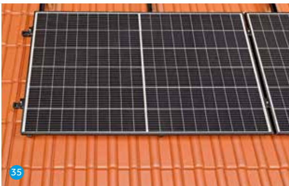
Fertig verlegtes Modulfeld im Kreuzschienenverbund.
