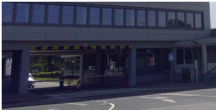
Durchfahrt mit Schrankenanlage vom Betriebsgelände aus betrachtet
