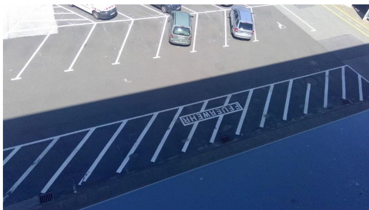
Vorhandene Aufstellfläche für Hubrettungsfahrzeuge vom 3. Obergeschoss aus betrachtet
